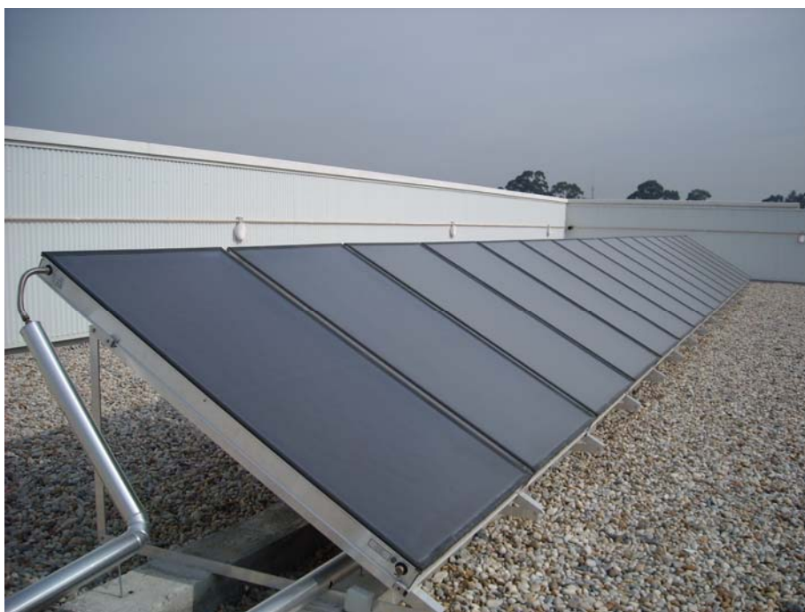
Figura 1.5 – Instalação de coletores
