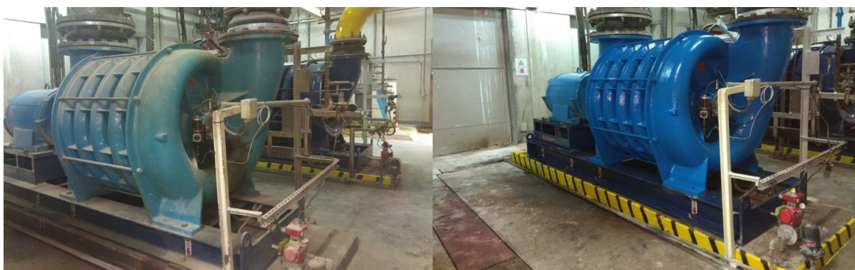
Figura 27 – Comparação do estado do compressor de gás de chaminé, antes e depois da atividade – vista geral (a)
