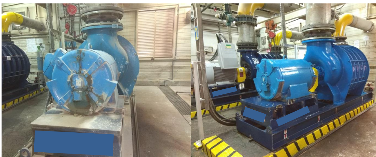
Figura 28 - Comparação do estado do compressor de gás de chaminé antes e depois da atividade – vista geral (b)
