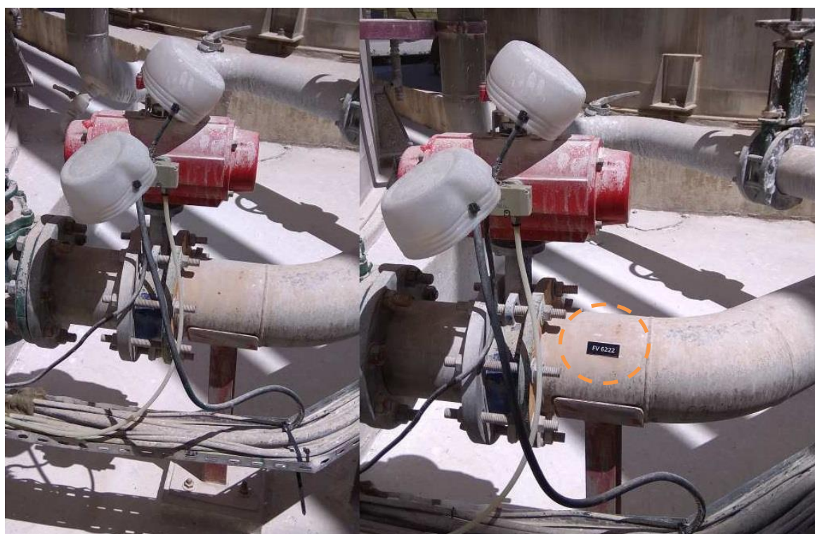
Figura 15 - Antes e depois, placa de identificação
