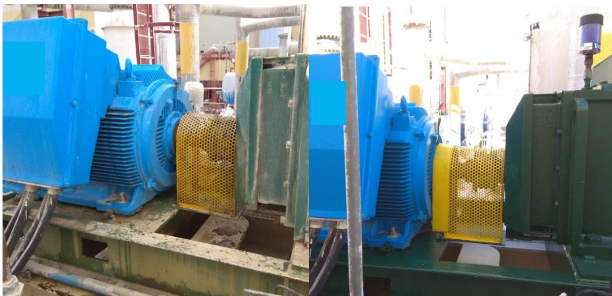
Figura 36 - Comparação do estado do agitador, antes e depois da atividade - marcações de lubrificação e tampas reparadas
