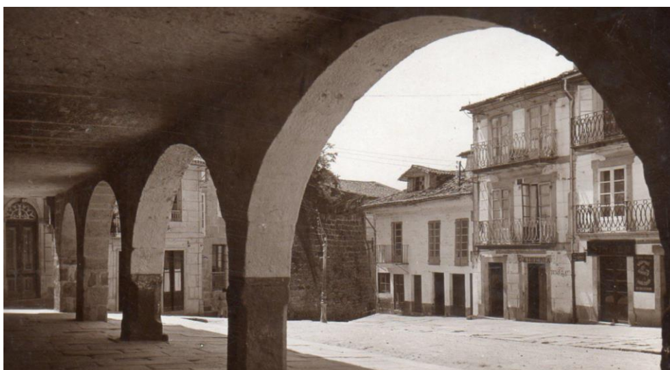
I 103. Vista desde los soportales de la vivienda demolida para la construcción un edificio.
