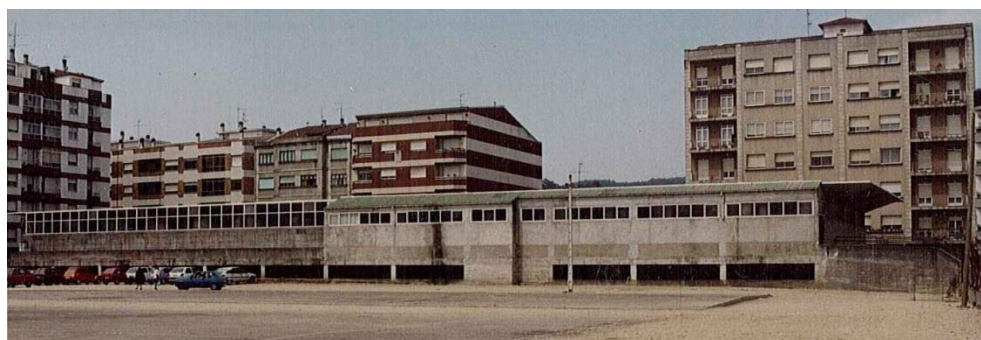
I 145. Antigua plaza de abastos antes de su demolición.
