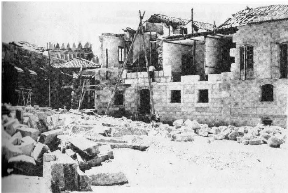
I 110. Plaza de San Fernando durante la reconstrucción de la edificación lateral a la Catedral.
