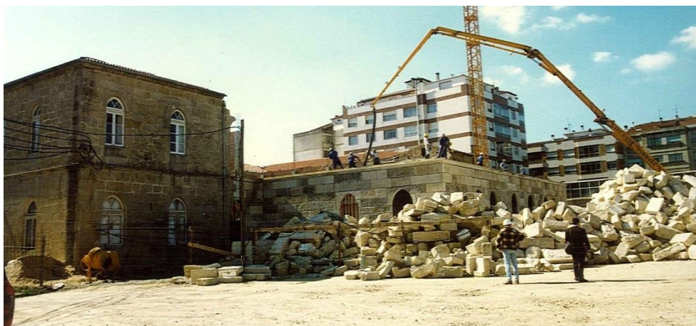
I 148. Trabajo de reconstrucción.
