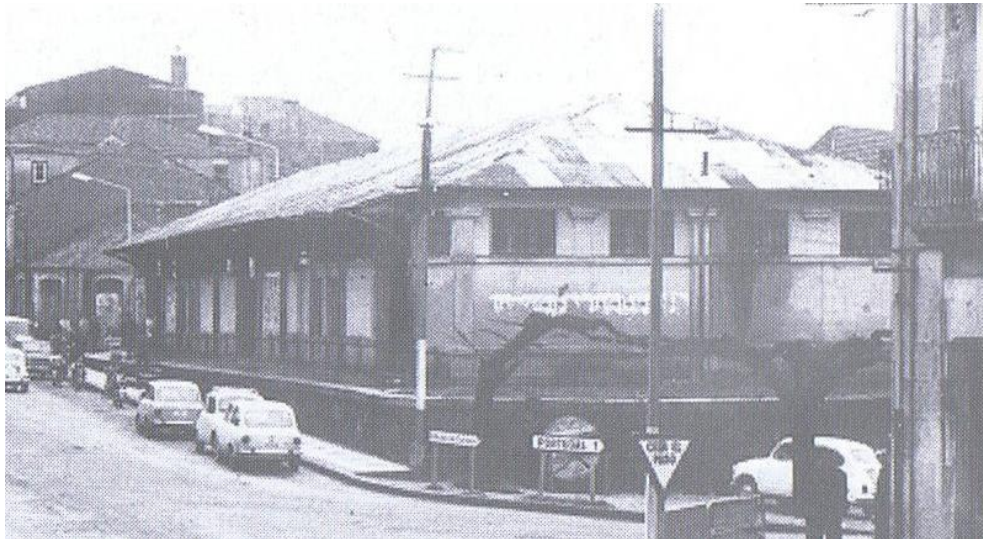
I 98. Plaza de abastos en 1.970, preparada para ser demolida.
