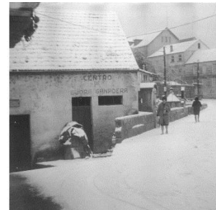
I 75. Lavadero Tripes y matadero.
