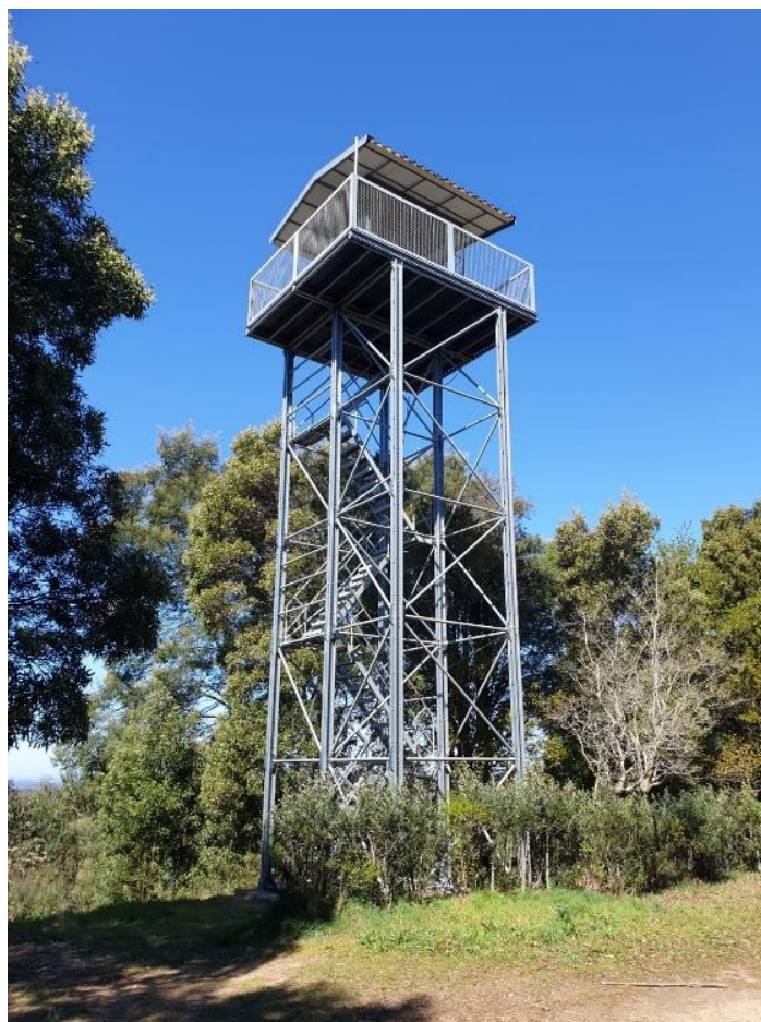
Figura 20 - Fotografia atual do Posto de Vigia da Senhora do Socorro, Albergaria-a-Velha
