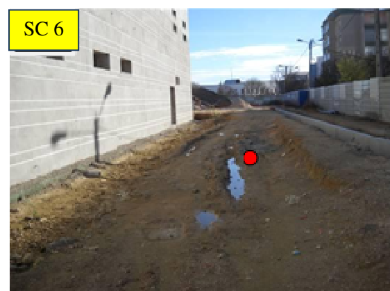
Figura 105 – Localização da sondagem SC6. (12)
