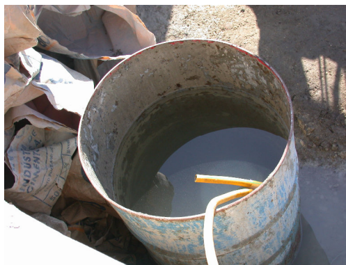
Figura 147 – Água – Preparação da calda de cimento
