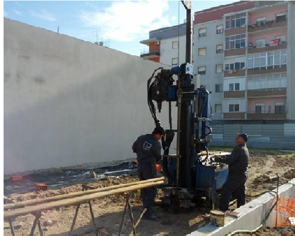
Figura 106 – Sonda de perfuração OXIDRLL, modelo OG150
