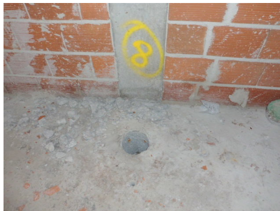
Figura 137 – Marcação das microestacas.
