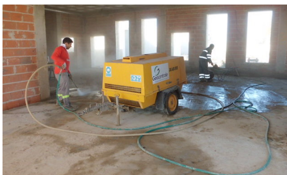
Figura 136 – Limpeza geral da obra.
