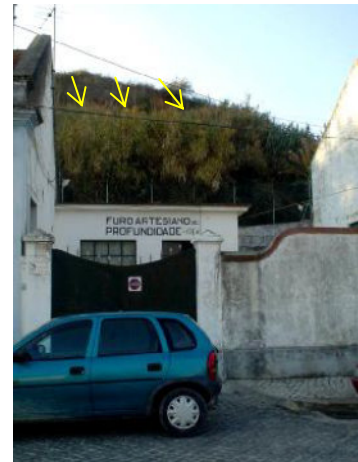
Figura 14 - Vista do deslizamento.
