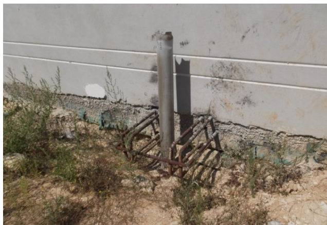
Figura 131 – Pormenor da armadura de amarração da microestaca (127) ao Pilar P18.
