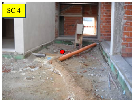
Figura 103 – Localização da sondagem SC4. (12)
