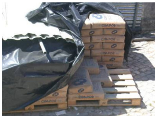
Figura 146 – Cimento – Preparação da calda de cimento
