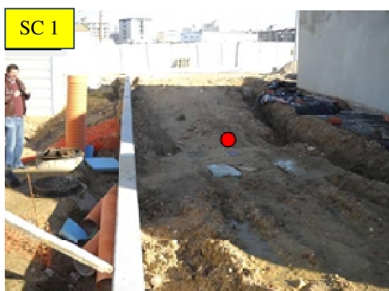
Figura 100 – Localização da sondagem SC1. (12)
