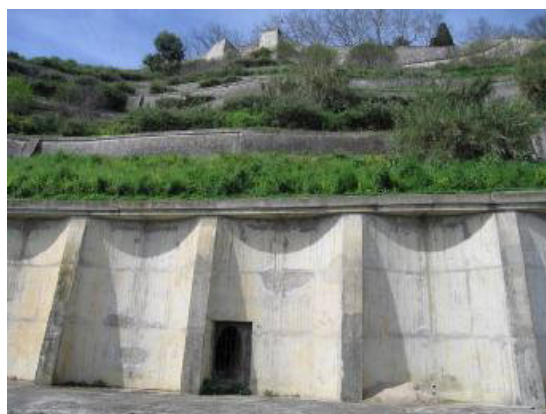
Figura 44 - Encosta, muros de contenção
