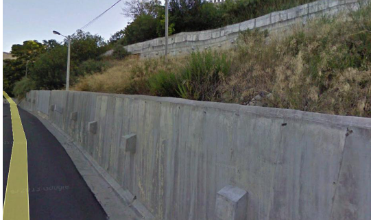
Figura 49 - Pormenor - muros de contenção. (4)
