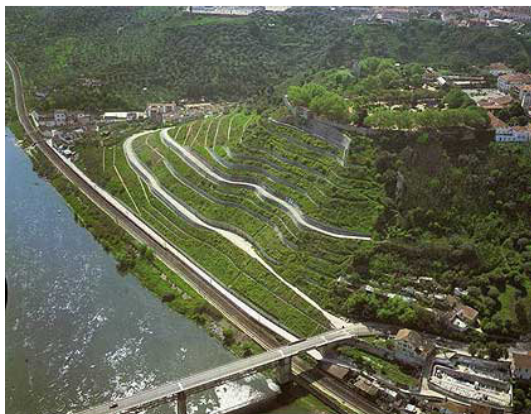
Figura 43 - Vista geral da encosta. (9)
