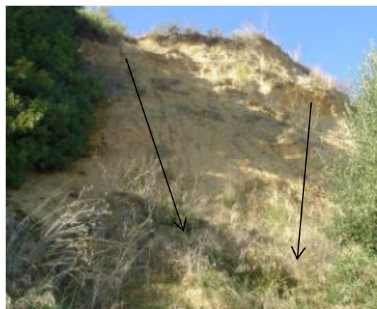
Figura 16 - Vista da encosta - Deslizamento
