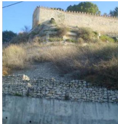
Figura 53 - Muros de gabiões sobrepostos por betão projectado sobre rede metálica.
