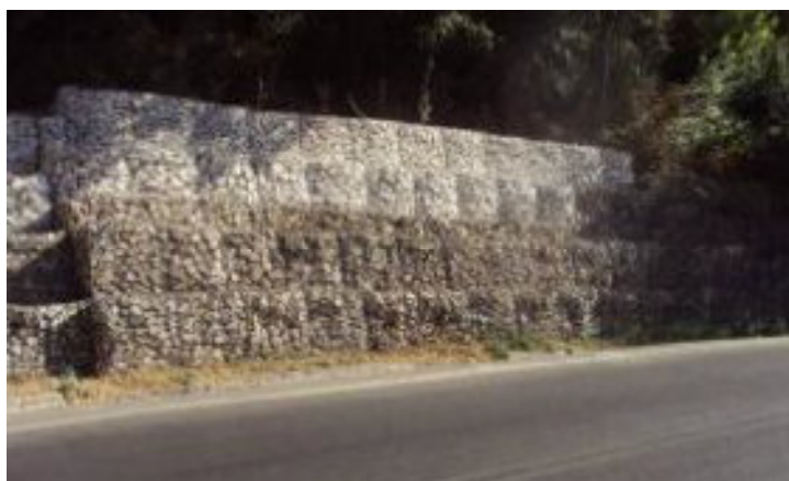
Figura 38 - Base da encosta – Alteamento do muro de gabiões.
