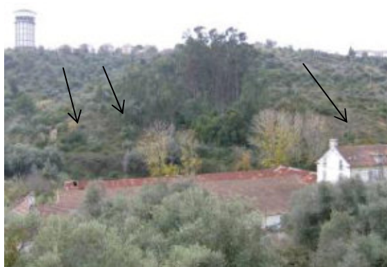
Figura 12 - Vista geral da encosta- Identificação de alguns deslizamentos.. (9)
