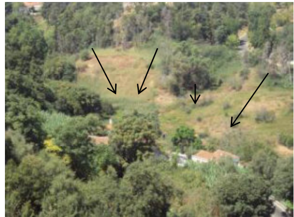
Figura 26 - Vista da encosta, deslizamentos.
