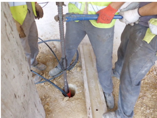
Figura 144 – Armadura secundária – Varão
