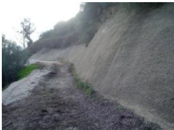
Figura 73 – Nivelamento da base – Betão projectado no talude. (9)
