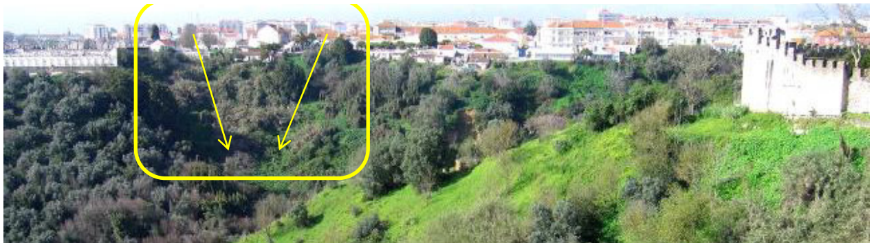
Figura 63 – Vista geral da encosta, deslizamento.
