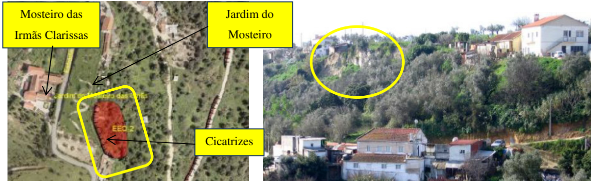
Figura 67 – Localização do deslizamento. (9) Figura 68 – Vista geral da encosta - Deslizamento. (9)
