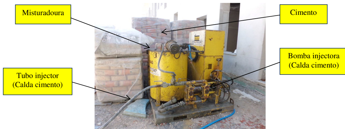
Figura 148 – Misturadora com bomba injectora – Preparação da calda de cimento.
