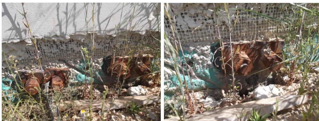
Figura 134 e 135 – Pormenores da amarração da microestaca.
