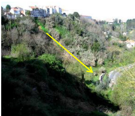
Figura 28 - Localização do deslizamento
