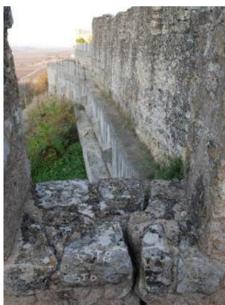
Figura 37 - Muro de betão armado, reforço da muralha.
