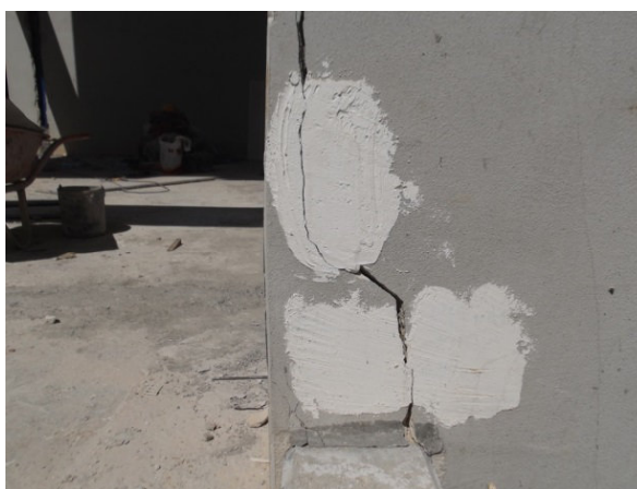
Figura 155 – Testemunho em gesso colocado na zona de régua topográfica R14
