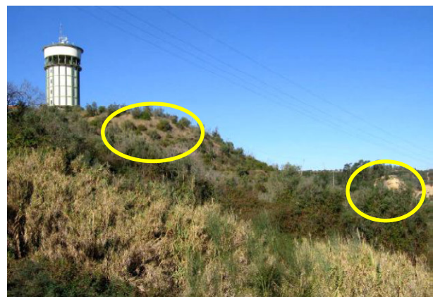
Figura 20 - Vista da encosta - Deslizamentos.
