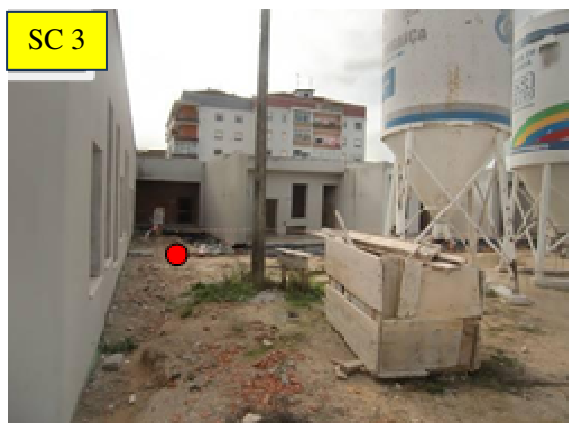
Figura 102 – Localização da sondagem SC3. (12)
