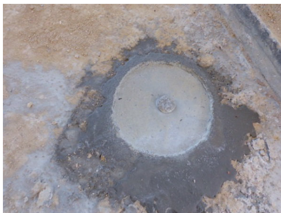
Figura 150 – Selagem das zonas caroteadas.
