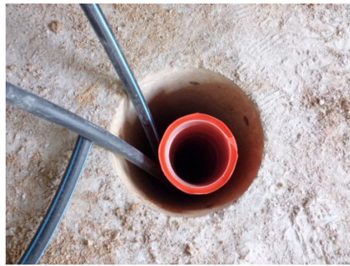
Figura 143 – Armadura principal com os obturadores ara injeção das caldas.
