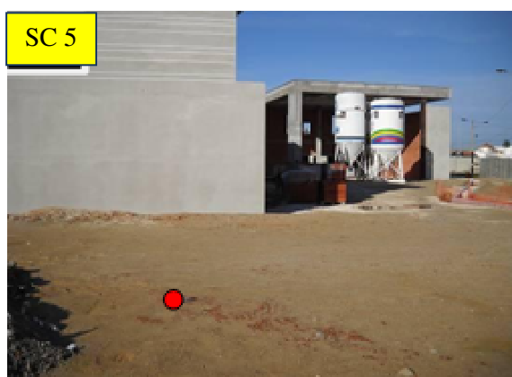
Figura 104 – Localização da sondagem SC5. (12)
