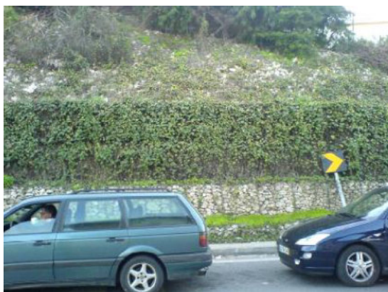
Figura 46 - Muro de gabiões junto à EN 114.
