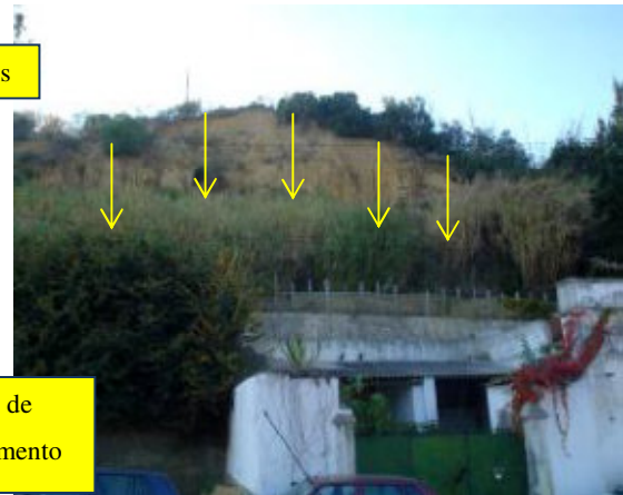
Figura 18 - Vista da encosta.
