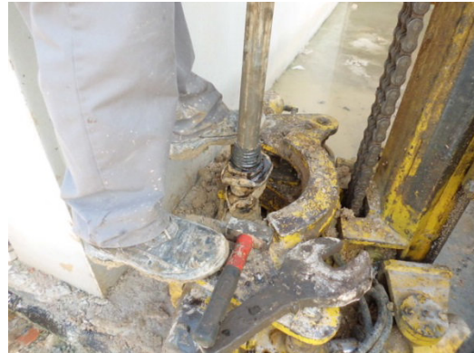
Figura 141 – Perfuração com varas.
