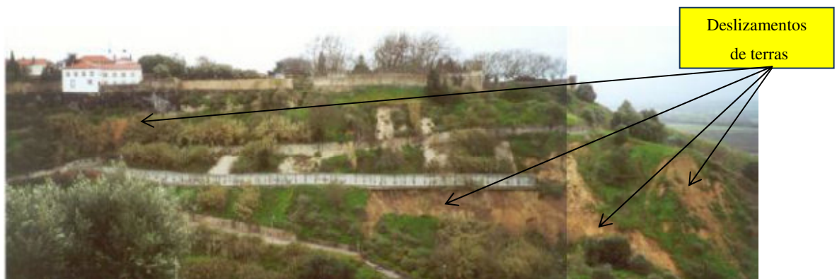
Figura 48 - Localização dos deslizamentos na encosta. (9)
