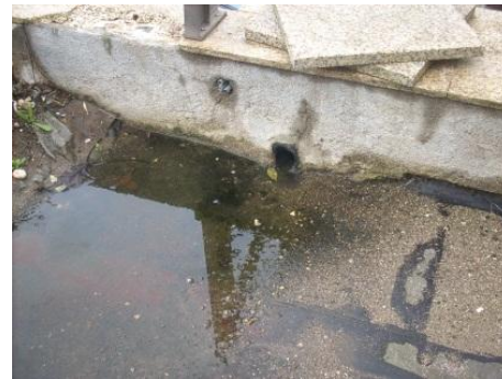
Figura. 108 - Acumulação de resíduos de construção
