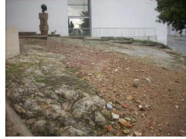
Figura. 83 – Entrada para o museu dificultada pelo desnível e condições do terreno
