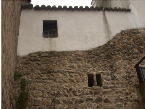
Figura. 43 – Fachada posterior, utilizando a muralha como parede de suporte
