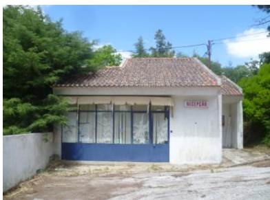
Figura. 157 - Receção / Habitação do vigilante (1)
