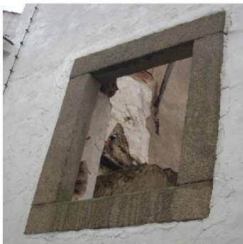
Figura. 53 – Vão em blocos de granito bujardado
