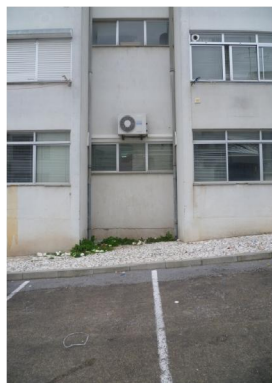
Figura. 137 - Zona onde se irá colocar a rampa metálica
