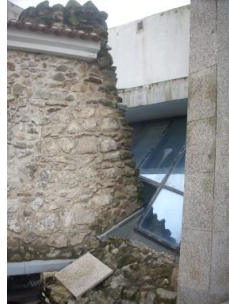
Figura. 105 - Utilização da muralha medieval como estrutura de suporte ao alçado posterior
