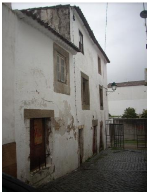
Figura. 41 – Beco da Rua da Figueira
