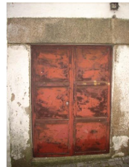
Figura. 55 – Caixilharia em ferro
