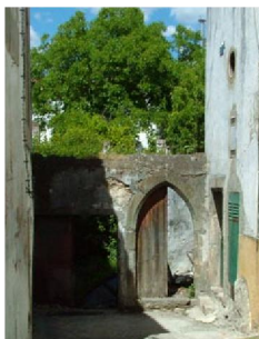
Figura. 9 – Porta Falsa (fonte: CMP)
