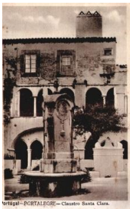
Figura. 18 – Claustros do Convento de Santa Clara
