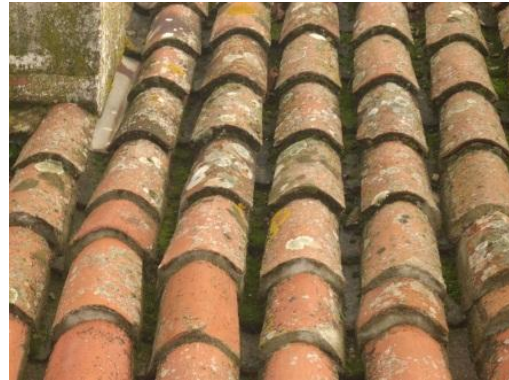
Figura. 92 – Pormenor da colocação das telhas
