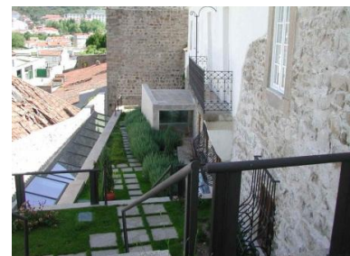
Figura. 103 - Segundo e terceiro patamar e da cobertura
