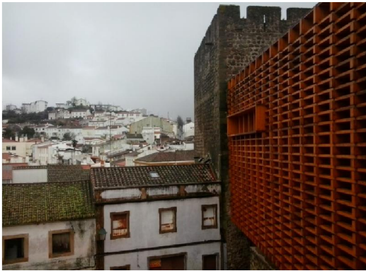
Figura. 147 - Estrutura de ligação entre a torre e o Pátio de Armas
