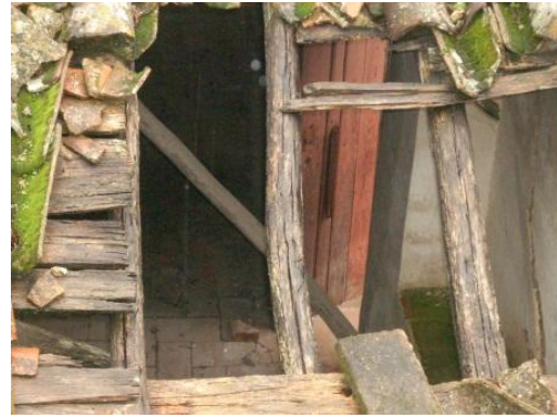
Figura. 52 – Estrutura da cobertura em madeira
