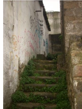
Figura. 44 – Caminho da ronda que permite o acesso à torre da muralha
