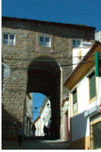
Figura. 10 – Porta da Devesa (fonte: CMP)
