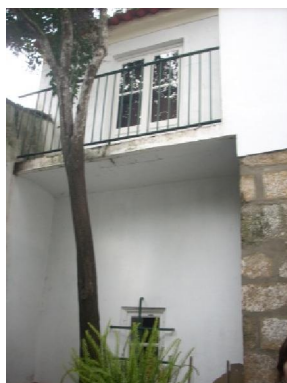
Figura. 89 – Árvore localizada junto ao edifício
