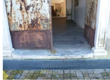
Figura. 127 - Porta da entrada principal
