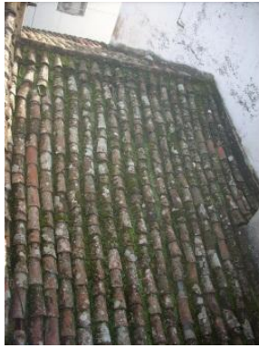
Figura. 51 – Cobertura em telha canudo
