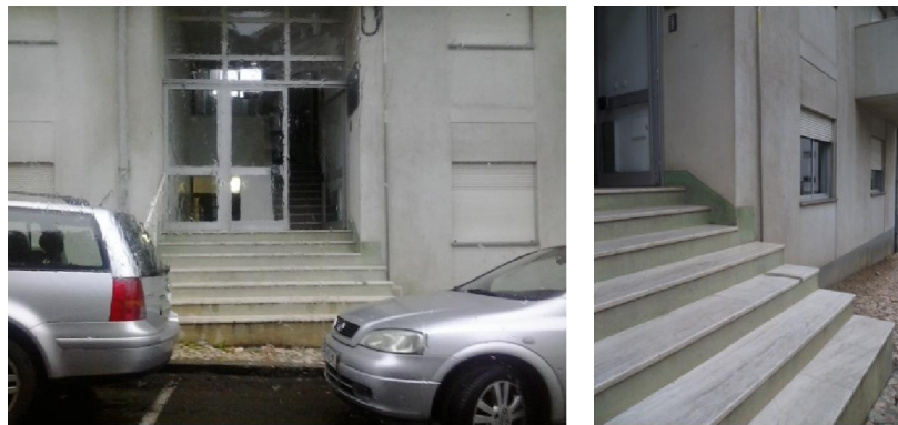
Figura. 136 - Acesso à Administração Regional Hidrográfica do Tejo
