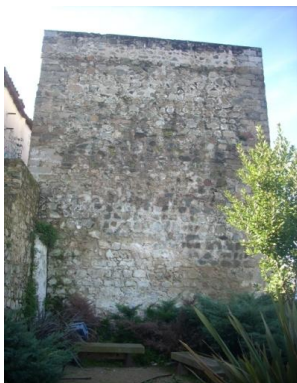
Figura. 34 – Torre da muralha Medieval
