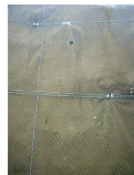
Figura. 117 - Observação da malha de ancoragens e de muro estável
