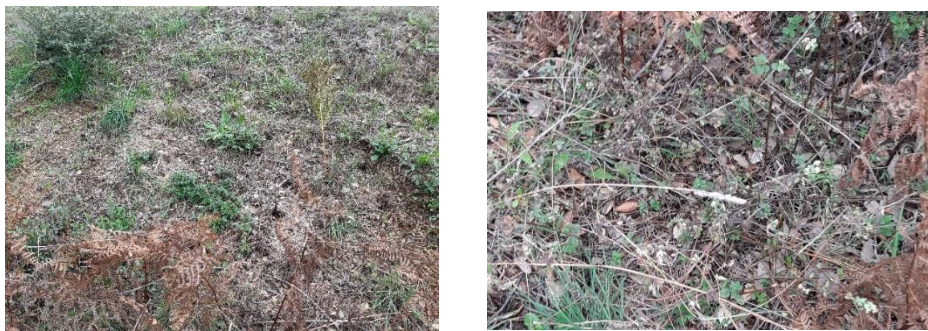
Fig. 32 - Evidências de corte das plantas no talude (OV12 – Arronches).
