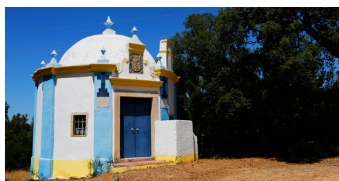
Fig 65 - Alvega - Capela Nossa Senhora da Guia
