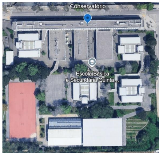
Figura 20 - Vista aérea do Conservatório
