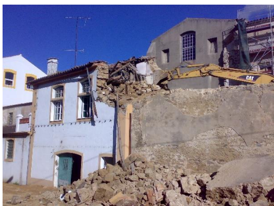
Figura 5 - Demolição da habitação anexa à Igreja de São Francisco
