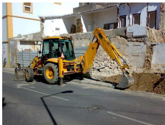
Figura 6 - Carga e transporte dos produtos resultantes da demolição a vazadouro
