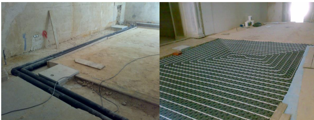
Figura 10 - Instalação de coletores e piso radiante
