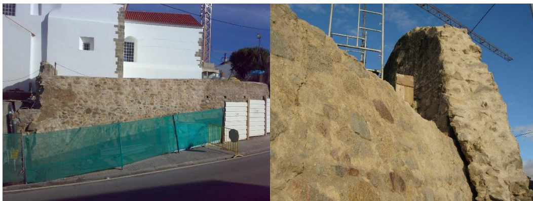
Figura 70 - A Cerca após a recuperação
