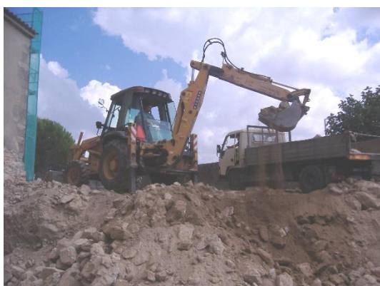
Figura 1 - Escavação e transporte de produtos resultantes a vazadouro na área envolvente à Igreja
