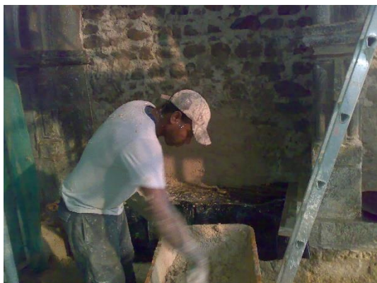
Figura 7 - Início do salpisco e emboço no interior na Capela Lateral do Altar do Lado da Epístola
