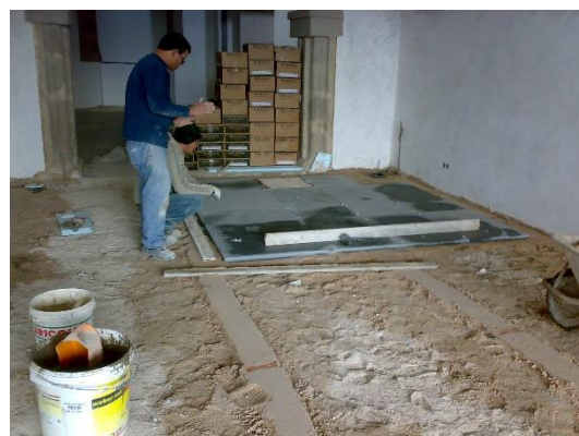
Figura 11 - Execução do revestimento do piso em granito
