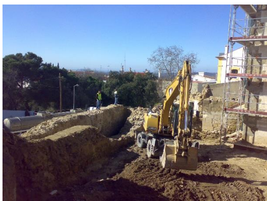
Figura 9 - Acompanhamento arqueológico da demolição dos edifícios anexos à Igreja de São Francisco e às estruturas arqueológicas descobertas
