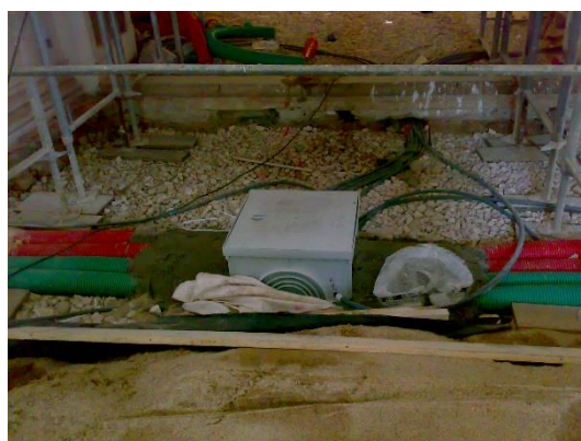
Figura 2 - Execução de infraestruturas elétricas
