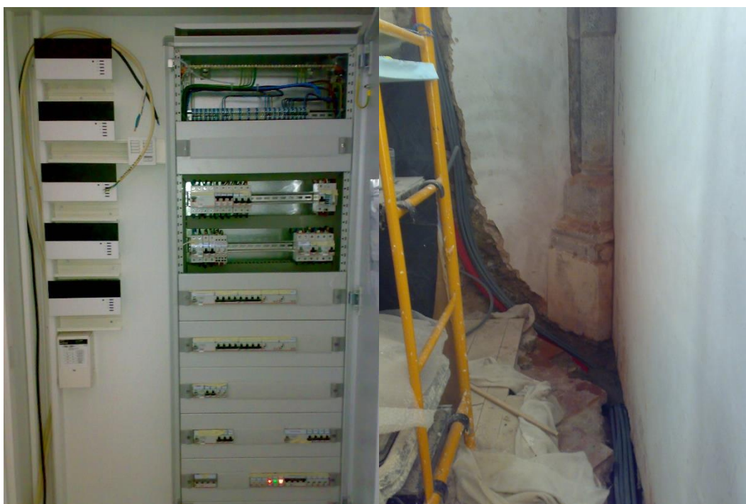
Figura 11 – Execução de infraestruturas elétricas – Quadros e traçado alternativo de cabos
