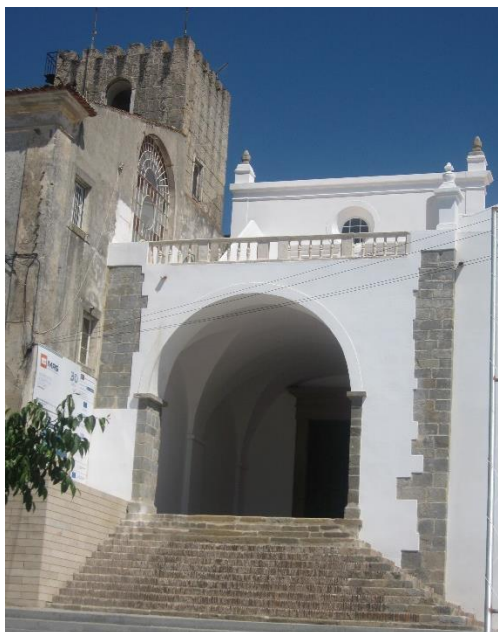
Figura 1 - Igreja do Convento de São Francisco
