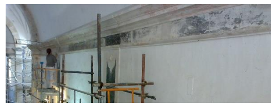
Figura 64 - Remoção da cal na sanca
