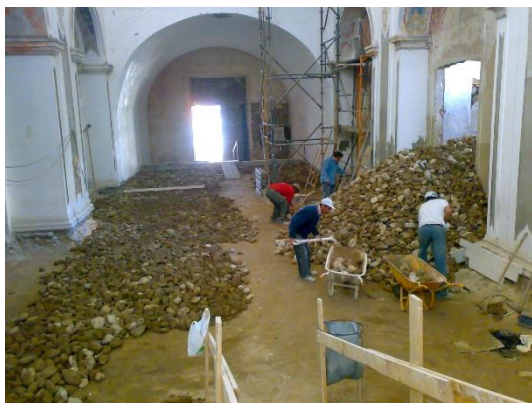
Figura 7 - Enrocamento para execução dos pavimentos no interior da Igreja
