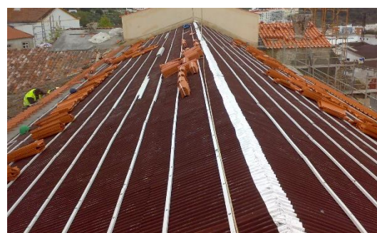
Figura 76 - Aplicação de subtelha e de réguas em pvc
