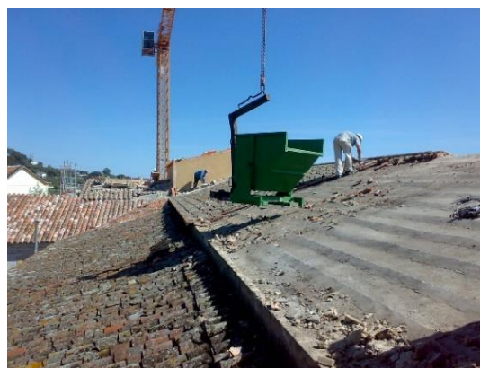
Figura 74 - Remoção do revestimento existente da cobertura
