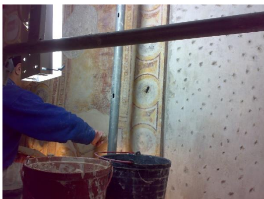
Figura 9 - Intervenção de conservação da pintura mural na primeira Capela da Nave do lado da Epístola
