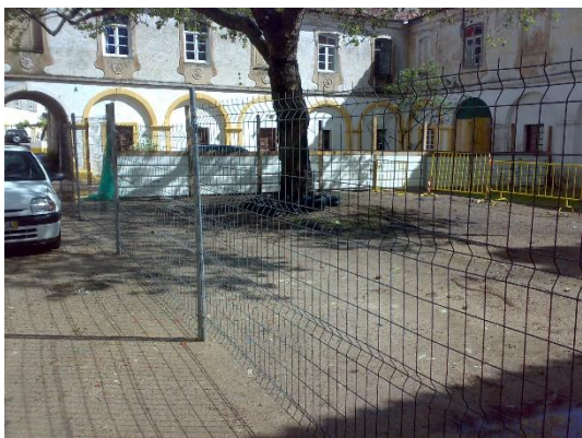
Figura 3 - Execução de vedação nos Claustros junto à Igreja
