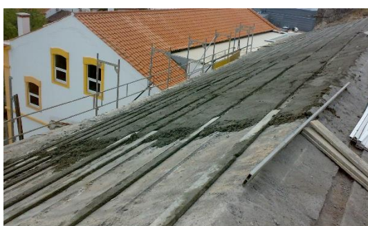
Figura 75 - Nivelamento e alinhamentos da superfície
