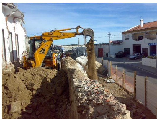
Figura 3 - Escavação na zona junto à Igreja incluindo o transporte de terras a vazadouro
