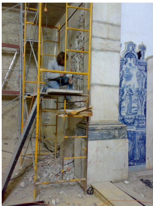
Figura 4 - Picagem das paredes interiores de forma manual e mecânica
