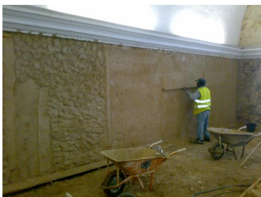
Figura 1 - Execução de encasques, emboço e reboco das paredes interiores da Igreja
