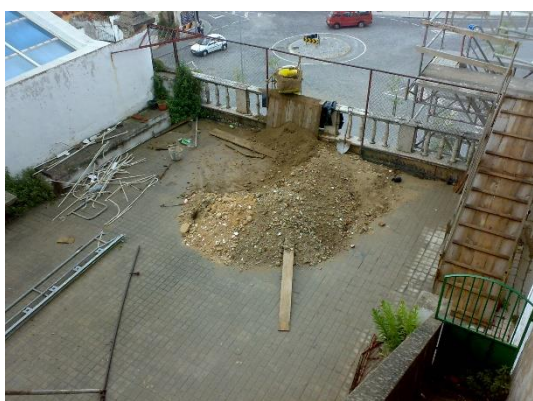
Figura 5 - Remoção dos produtos existentes no terraço a vazadouro
