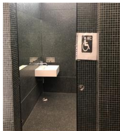
Figura 96 - Porta de acesso
