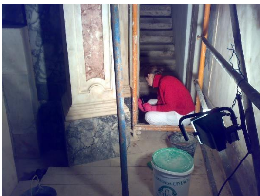
Figura 11 - Intervenção de conservação de Estuques no Altar-mor
