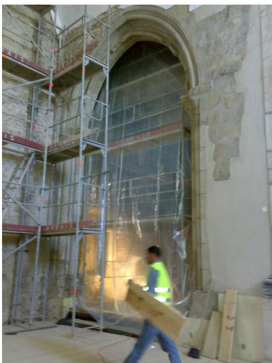
Figura 15 - Intervenção na abóbada e elementos pétreos da Capela Lateral do Lado do Evangelho
