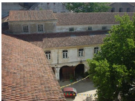
Figura 49 - Coberturas do Convento
