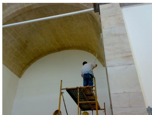
Figura 2 - Pintura de paredes interiores
