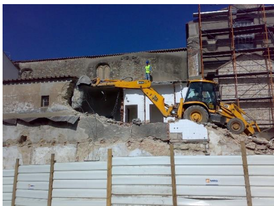
Figura 5 - Demolição da construção anexa à Igreja de São Francisco
