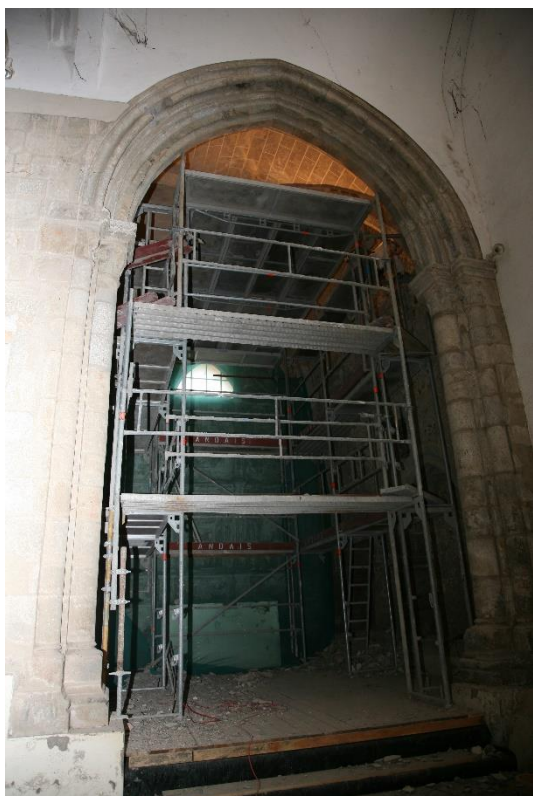
Figura 15 - Picagem dos estuques e rebocos na Capela Lateral do Altar do Lado do Evangelho e na Capela Lateral do Altar do Lado da Epístola
