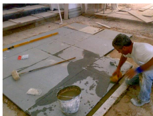
Figura 3 - Revestimento de pavimentos interiores em granito
