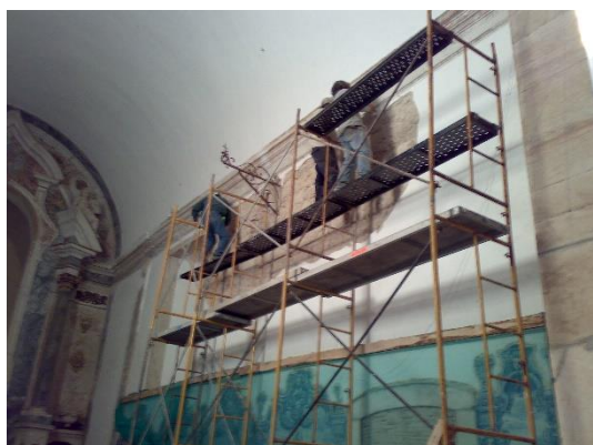
Figura 5 - Picagem das paredes interiores da Igreja
