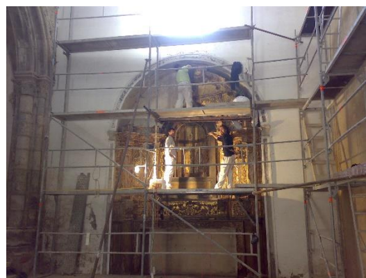
Figura 12 - Intervenção de conservação do Retábulo de Madeira
