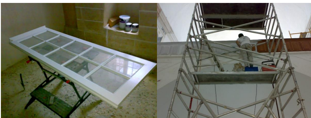
Figura 8 - Recuperação de carpintarias na Igreja
