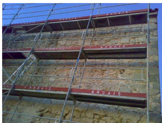
Figura 2 - Montagem de andaimes para a picagem das paredes exteriores da Igreja
