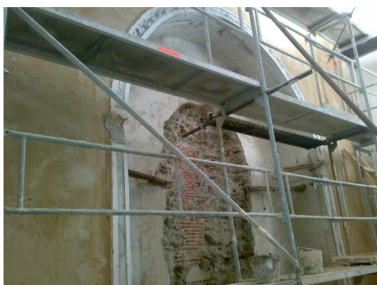
Figura 1 - Execução de reboco nas paredes interiores da Igreja
