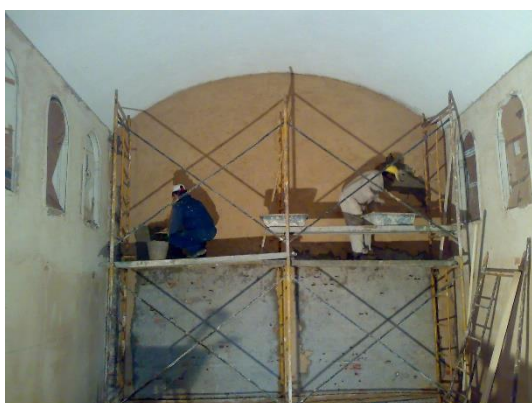
Figura 1 - Execução de reboco das paredes interiores da Igreja
