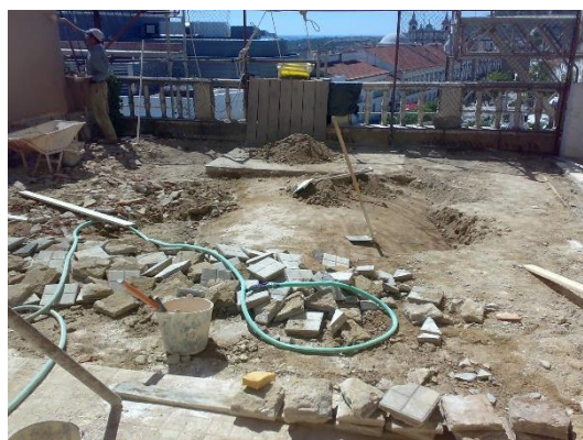
Figura 4 - Remoção do revestimento da cobertura da Galilé
