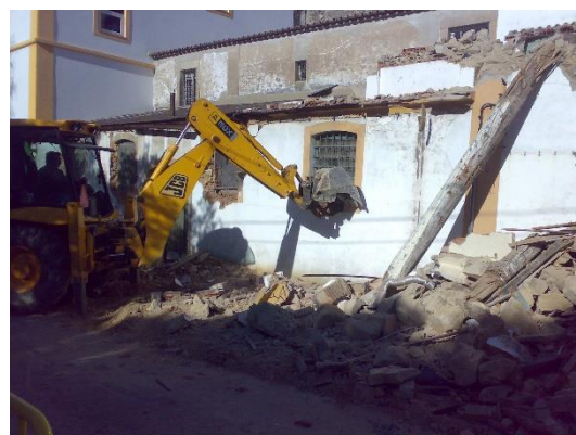
Figura 6 - Demolição do armazém anexo à Igreja de São Francisco
