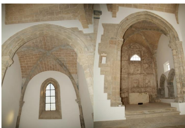
Figura 5 - Abóbada de ogiva das Capelas laterais do Altar com janelas de arco quebrado
