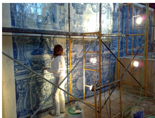
Figura 10 - Intervenção de conservação do revestimento azulejar da Capela-mor
