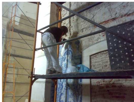
Figura 16 - Remoção do revestimento das paredes interiores junto aos painéis de azulejos na Capela-Mor
