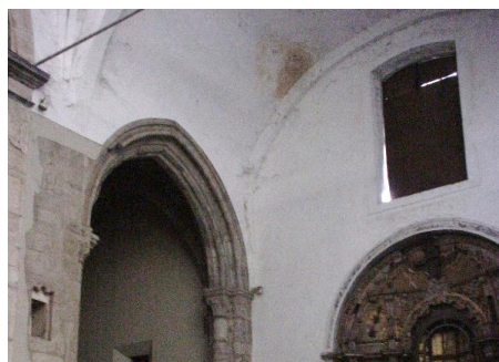
Figura 38 - Teto do transepto
