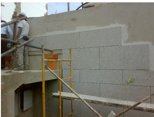
Figura 8 - Execução de revestimento em granito
