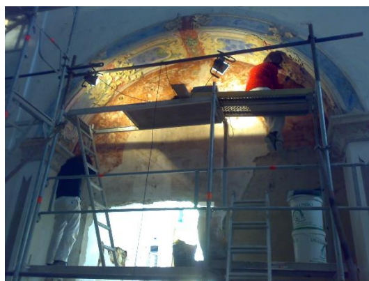
Figura 4 - Intervenção de conservação do segundo arco e pintura do lado do Evangelho
