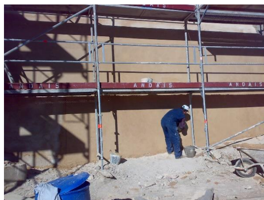
Figura 2 - Execução de reboco nas paredes exteriores da Igreja
