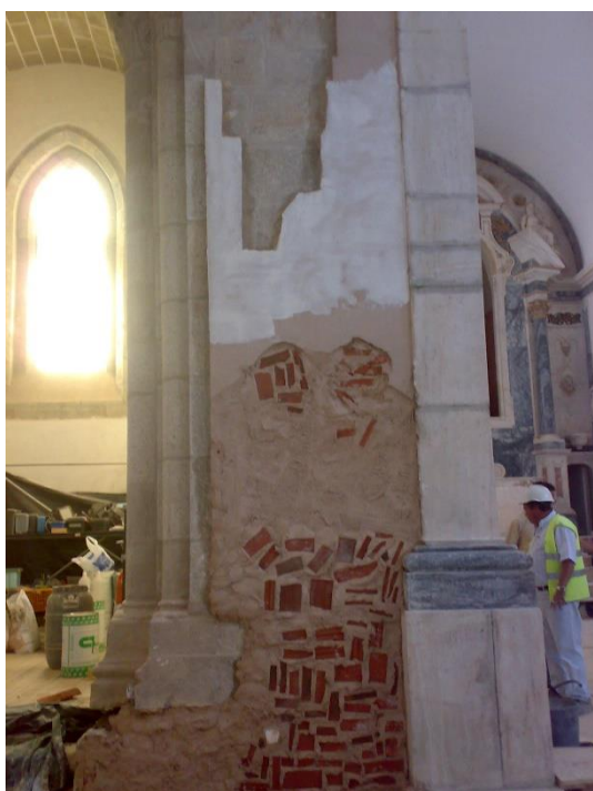
Figura 1 – Execução de encasque, emboço e reboco em cal aérea
