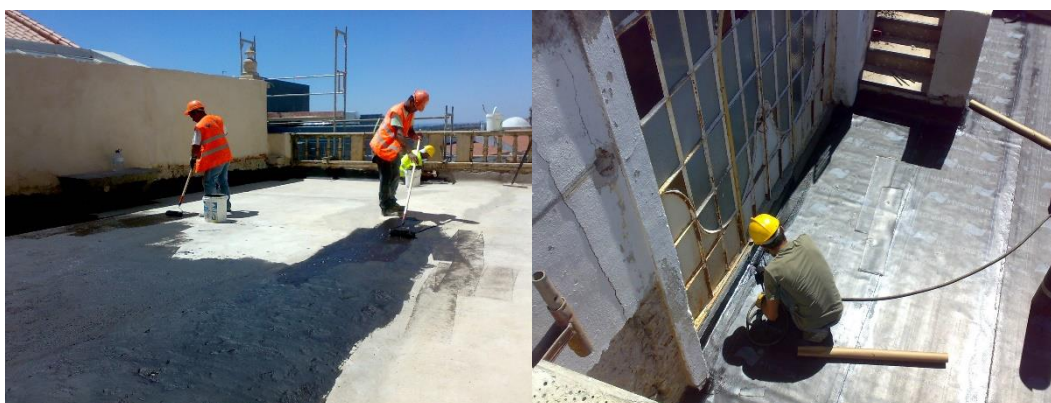
Figura 5 - Impermeabilização do terraço da Galilé
