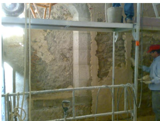
Figura 6 - Execução de encasques, emboço e reboco nas paredes interiores da Igreja
