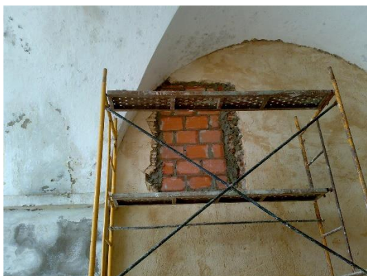
Figura 1 - Fecho dos vãos existentes na Galilé
