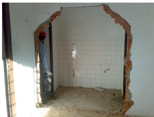
Figura 8 - Demolição de pavimentos e louças sanitárias no espaço correspondente à área expositiva 3
