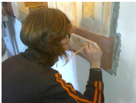
Figura 14 - Restauro do Altar em massa no tardo das Capelas Laterais da Nave
