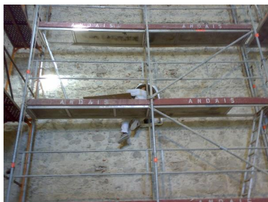
Figura 18 - Limpeza e restauro do nicho existente no Transepto do lado do Evangelho
