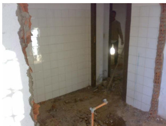
Figura 3 - Demolição das paredes interiores da instalação sanitária existente
