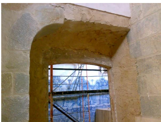
Figura 3 - Execução de reboco nos vãos na Capela-Mor
