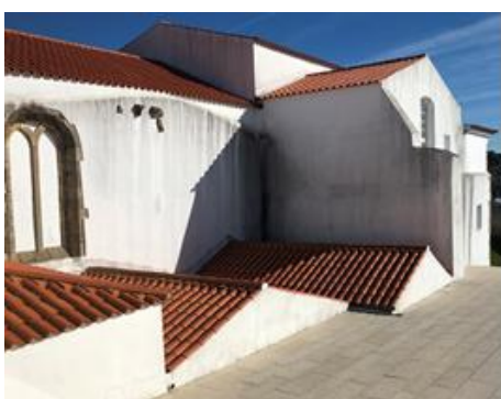
Figura 85 - Zona de transição entre as coberturas
