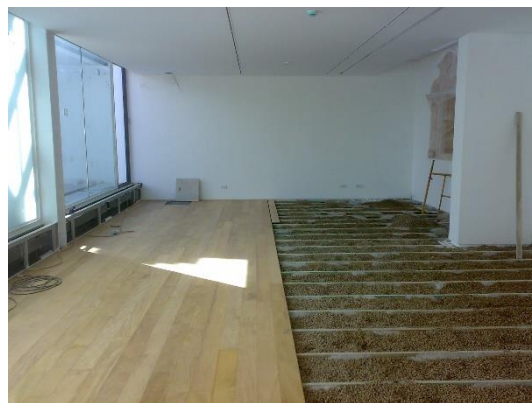
Figura 13 - Execução do revestimento do piso em madeira
