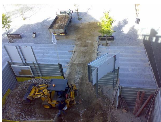
Figura 9 - Remoção e transporte dos produtos resultantes das picagens das paredes interiores e dos pavimentos a vazadouro
