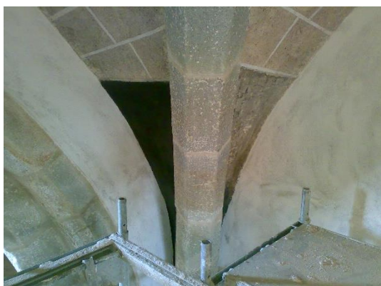
Figura 15 - Intervenção na abóbada e elementos pétreos das Capelas Laterais do Altar
