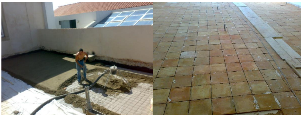
Figura 6 - Execução de camada de assentamento e aplicação do piso em tijoleira
