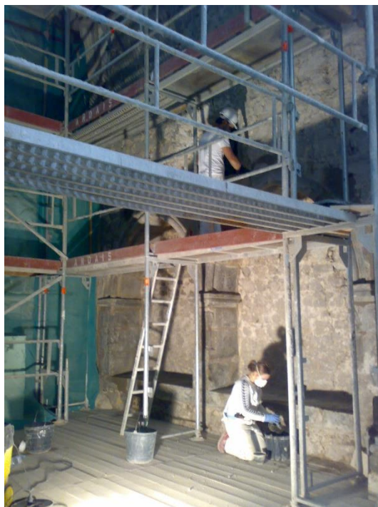
Figura 14 - Intervenção na abóbada e elementos pétreos da Capela Lateral do Altar do lado da Epístola
