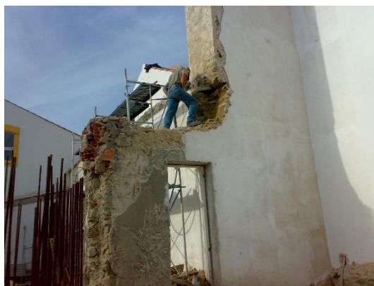
Figura 2 - Demolição de construção junto ao Contra Forte
