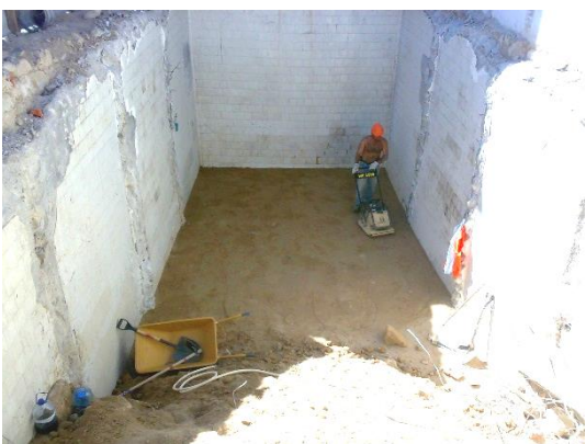
Figura 3 - Realização de aterro controlado dentro dos tanques
