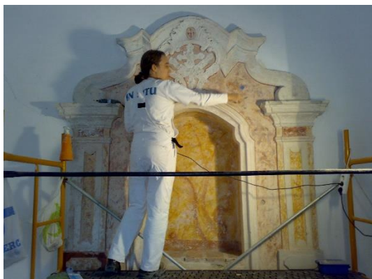
Figura 13 - Restauro do Altar em massa no tardo das Capelas Laterais da Nave
