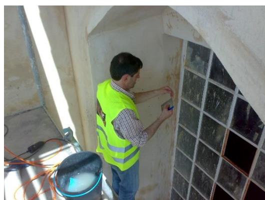
Figura 6 - Recuperação de vãos existentes e gradeamentos na Igreja
