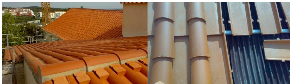
Figura 78 - Colocação do revestimento da cobertura
