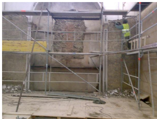
Figura 2 - Remoção dos revestimentos da parede interior (retábulo de madeira)
