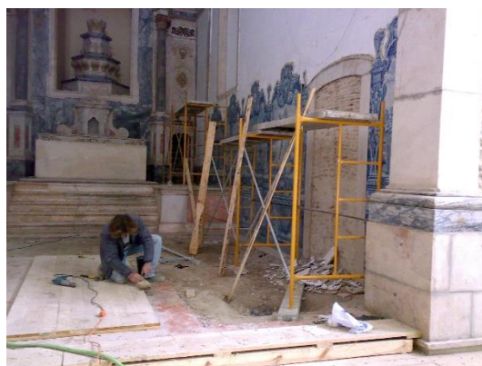
Figura 4 - Montagem de andaimes para picagem das paredes interiores da Igreja
