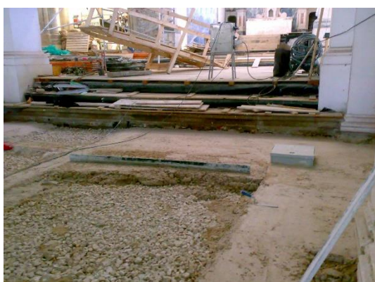
Figura 5 - Preparação dos pavimentos no interior da Igreja para receção de acabamentos
