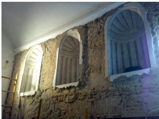
Figura 13 - Limpeza e restauro dos nichos da 2ª Capela Lateral da Nave do lado da Epístola
