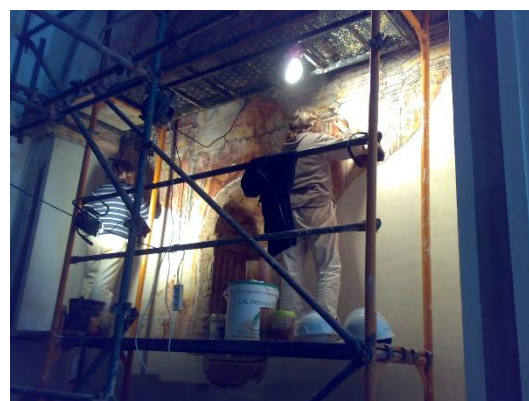
Figura 10 - Intervenção de conservação da pintura mural na primeira Capela da Nave do lado do Evangelho
