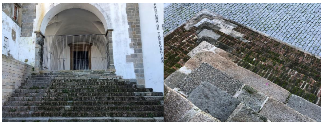
Figura 12 - Degraus da Igreja de São Francisco em pedra e tijolo
