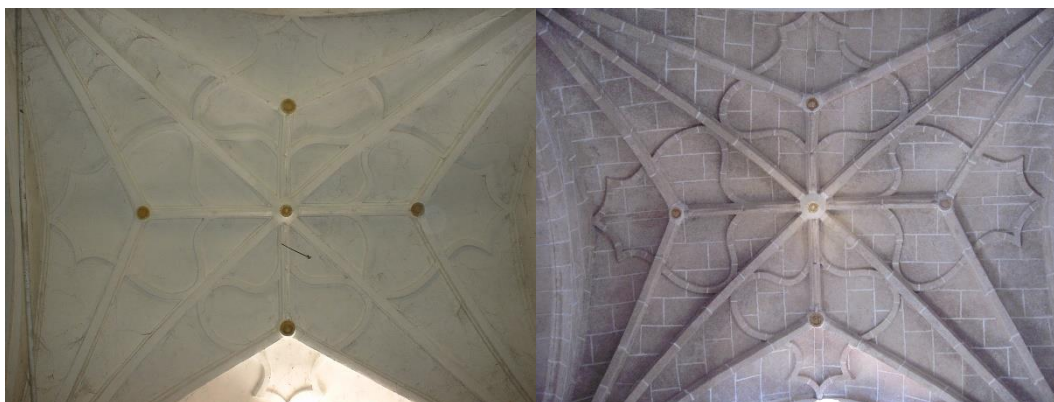
Figura 14 - Abóbada do transepto antes e depois das obras de recuperação
