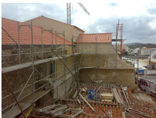
Figura 1 - Execução de reboco nas paredes exteriores da Igreja
