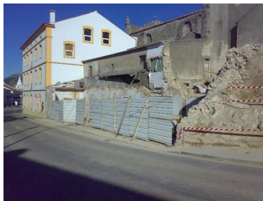
Figura 8 - Execução de vedação da área intervencionada (demolição de construções)
