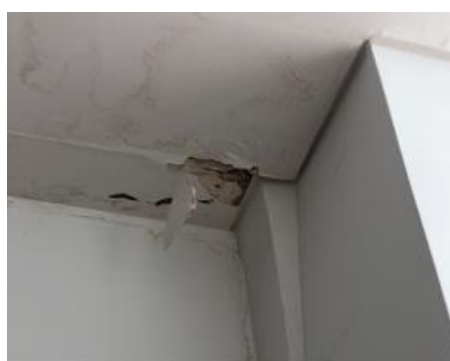
Figura 86 - Área dos tetos junto à zona de transição e drenagem de águas pluviais
