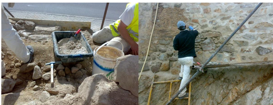
Figura 69 - Aplicação de argamassa de cal aérea
