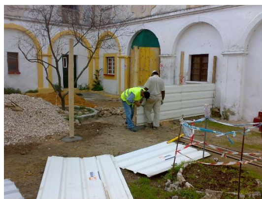
Figura 4 - Execução de vedação nos Claustros junto à Igreja
