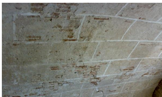
Figura 66 - Remoção do reboco de cal sobreposto
