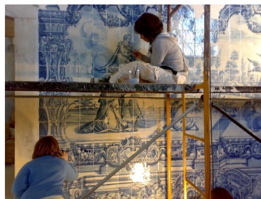
Figura 12 - Intervenção de conservação do revestimento azulejar da Capela-mor
