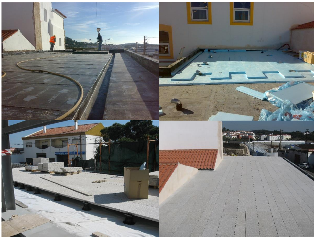
Figura 7 - Execução de impermeabilização e revestimento das coberturas
