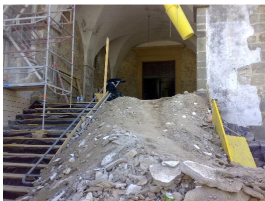
Figura 6 - Remoção e transporte dos produtos resultantes das picagens das paredes interiores e exteriores a vazadouro
