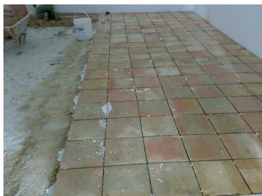
Figura 4 - Revestimento de pavimentos interiores em tijoleira
