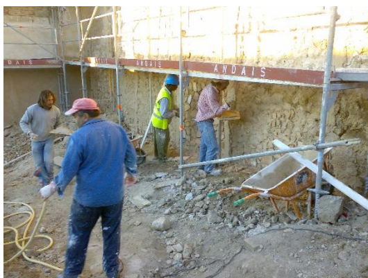
Figura 5 - Execução de encasques, emboço e reboco nas paredes exteriores da Igreja
