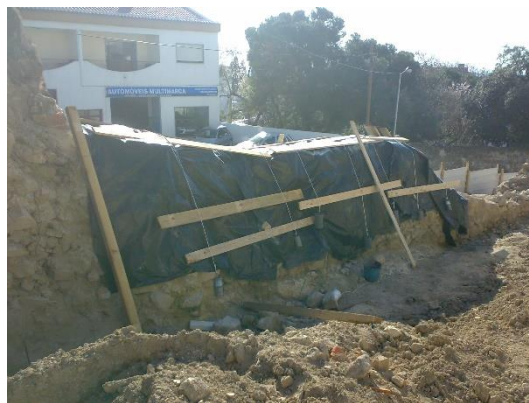
Figura 8 - Proteção da estrutura arqueológica (Cerca)
