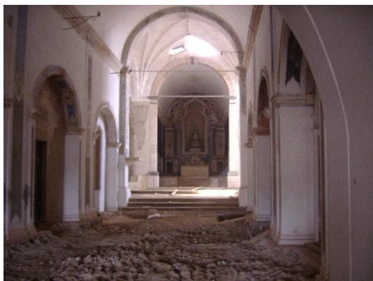
Figura 7 - Remoção de pavimentos interiores em tijoleira
