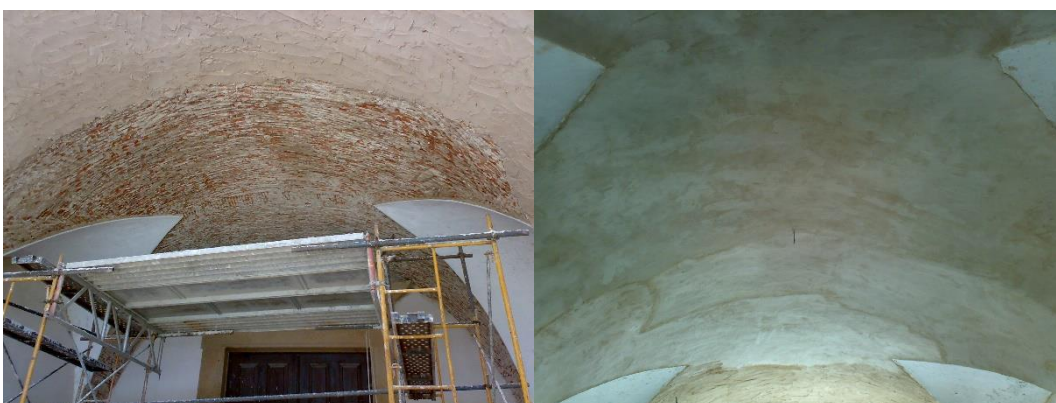
Figura 7 - Revestimento de tetos em argamassa de cal
