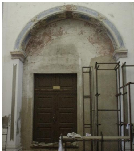
Figura 45 - Abertura de vão
