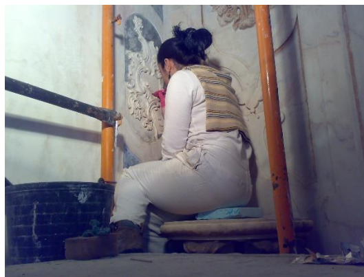
Figura 8 - Intervenção de conservação de estuques no Altar-mor
