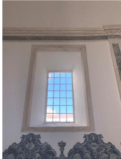
Figura 25 - Vão na Capela-mor
