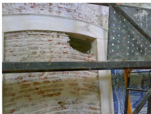
Figura 2 - Execução de sondagens nos vãos da Capela-Mor
