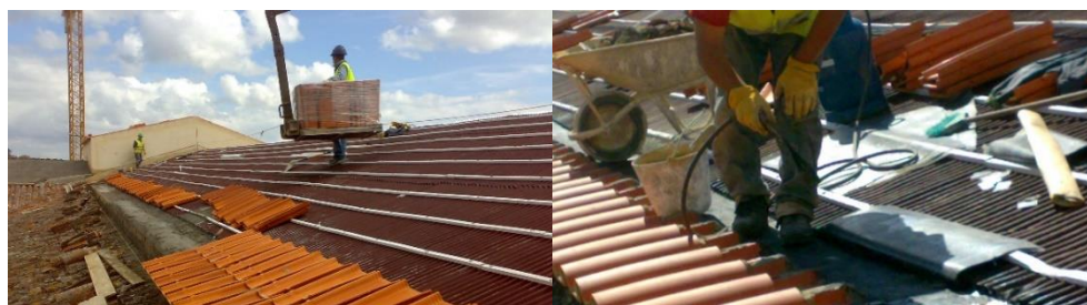
Figura 77 - Execução de beirado
