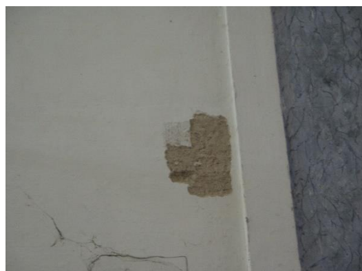
Figura 17 - Sondagens para trabalhos de Conservação e Restauro
