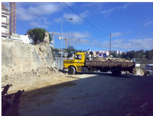
Figura 7 - Carga e transporte dos produtos resultantes da demolição a vazadouro
