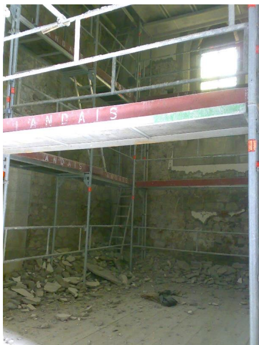
Figura 3 - Montagem de andaimes para picagem das paredes interiores e restauro dos tetos das Capelas Laterais à Capela-Mor
