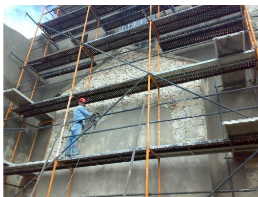
Figura 2 - Remoção dos revestimentos das paredes exteriores da Igreja
