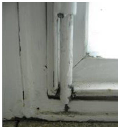
Figura 95 – Pormenor de fecho e pintura
