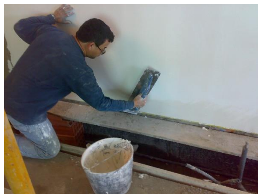
Figura 9 - Execução de revestimento de paredes interiores
