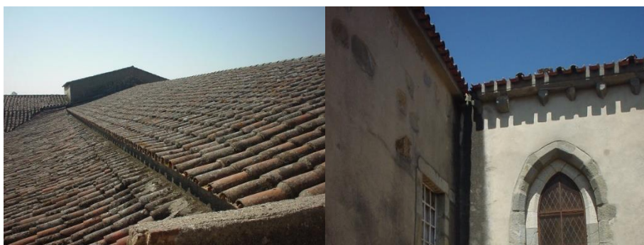
Figura 36 – Revestimento e beirado da cobertura da igreja
