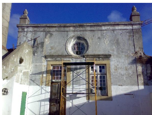
Figura 3 - Picagem das paredes exteriores ate ao novo contraforte e da fachada da Galilé
