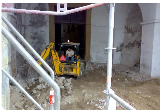
Figura 6 - Remoção de pavimento exterior existente na Galilé
