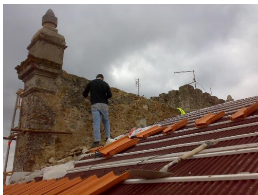
Figura 2 - Remoção de revestimentos e execução de reboco nas paredes exteriores da Igreja
