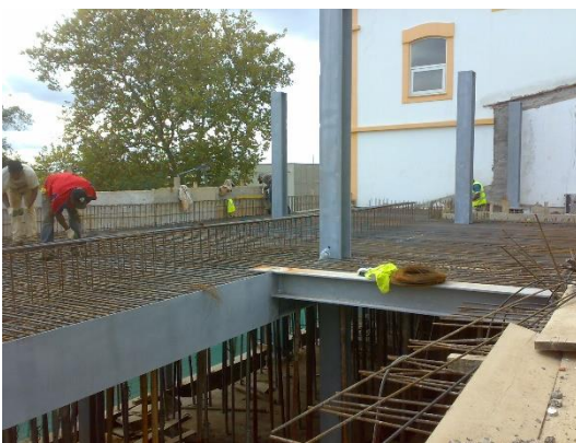
Figura 5 - Execução de elementos estruturais
