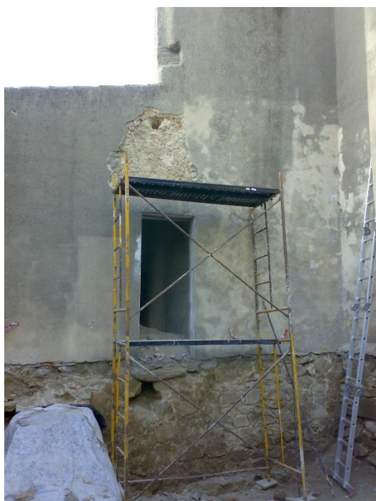
Figura 1 - Execução de sondagem no contraforte
