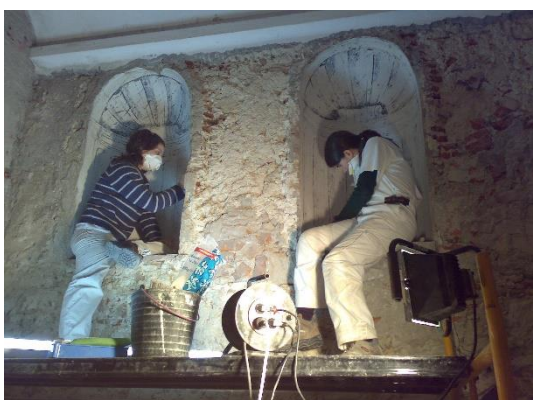
Figura 17 - Limpeza e restauro dos nichos da 2ª Capela Lateral da Nave do lado da Epístola
