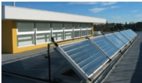
Figura 18: Instalação de coletores solares térmicos (Implicações, soluções de design e exemplos, presentation to PhD course FCT-UN).
