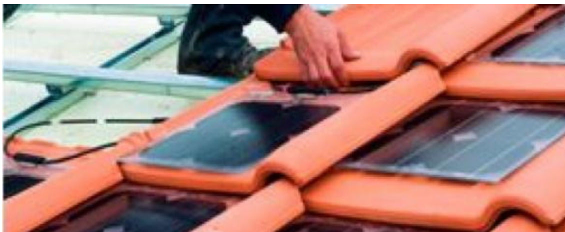
Figura 35: Montagem de telhas solares (energia solar fotovoltaica de A. Fuentes. M. Álvarez)
