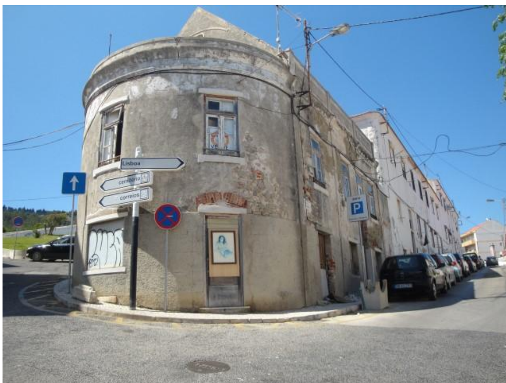
Figura 30: Edifício existente (foto tirada 30 Outubro 2017)
