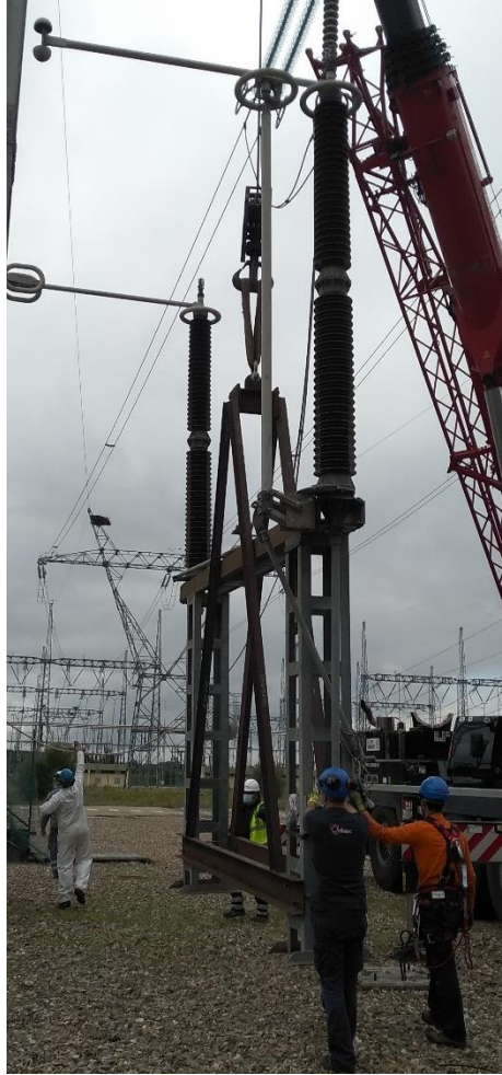
Figura 54 - Ferramenta para desmontagem do seccionador.
