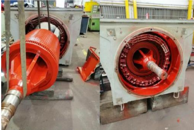
Figura 86 - Pintura epóxi e montagem do rotor [23].
