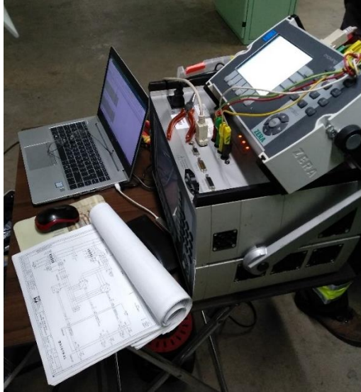
Figura 63- Equipamento para ensaios da Labelec.
