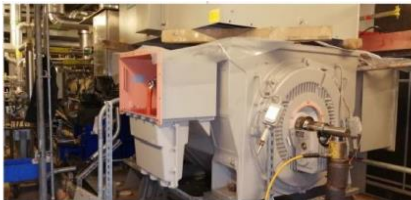
Figura 82 - Ensaio ao circuito refrigeração [23].
