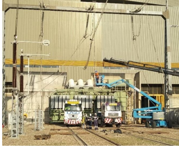
Figura 55 - Movimentação do transformador.
