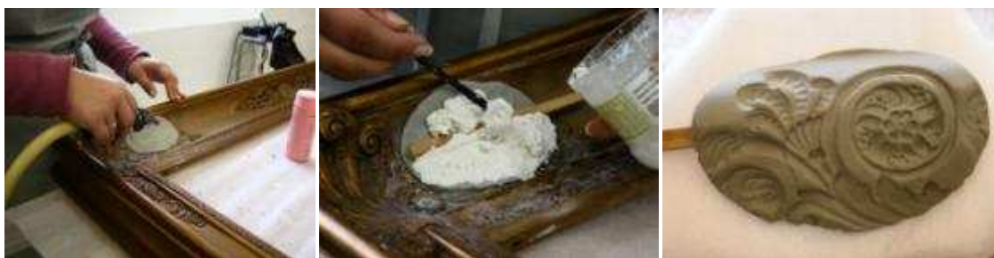
Imagem 31, 32 e 33 - Preparação do molde para a reconstrução do elemento em falta.
