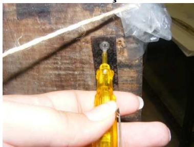
Imagem 72 - Remoção de elemento metálico.
