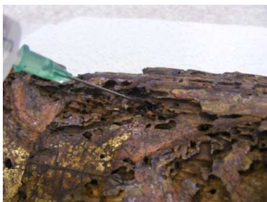
Imagem 59 - Consolidação por injeção do adesivo.
