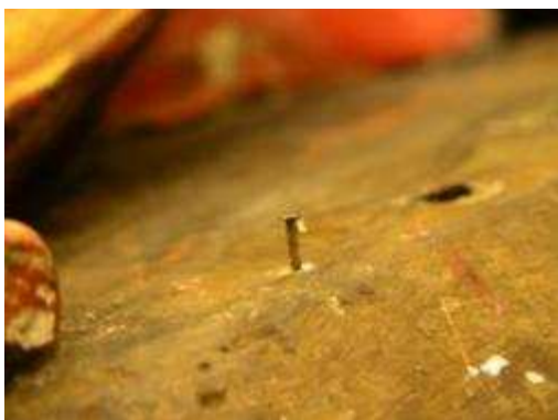
Imagem 16 - Elemento metálico na base.
