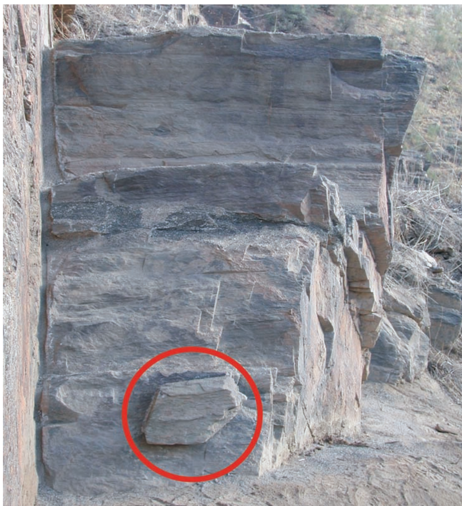
fig. 12, 13 e 14 Preenchimento de lacunas e fracturas com argamassa hidráulica à base de C30 (em cima, à esq.); ancoragem de um pequeno fragmento de xisto, propositadamente descontextualizado, com pernos de fibra de vidro, embebidos em resina epoxidica e argamassa fluida (em cima, à esq. e em baixo.).
