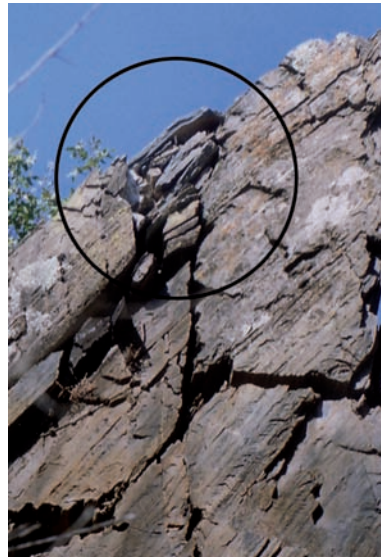
fig. 14 A forma como a parte da frente da rampa se integrou no conjunto. Utilizando material da mesma tipologia consegue-se uma harmonia do conjunto. Foto: Compósito.
