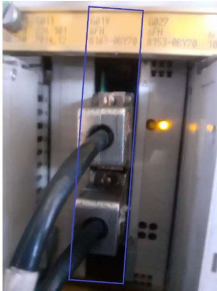
Figura 57 – Eurocard 6FH8163 atualizada, na posição G019 da rack da UCC da automotora UQE 2403/63, com as ligações ao bus do comboio (foto no parque oficial de Campolide).
