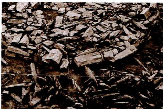
Pormenor das estruturas de contrafortagem na estrutura sub-circular (bastião) B. As lajes de xisto dispõem-se de forma paralela e perpendicular entre si, de forma a garantir a estabilidade do embasamento pétreo.
