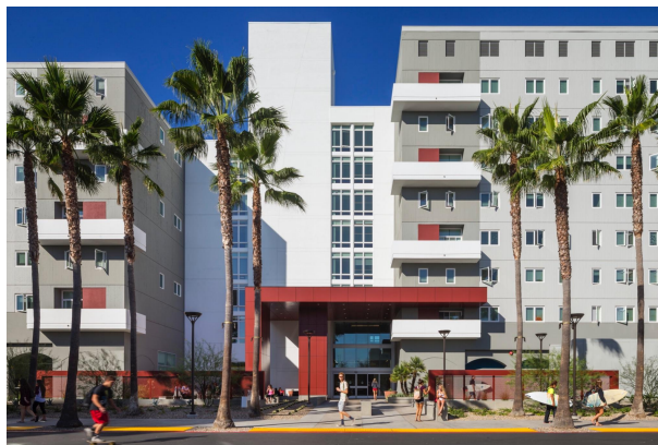
Fig.68. Representação da fachada exterior da residência Zura Hall. Fonte: (HMC Architects, 2020)
