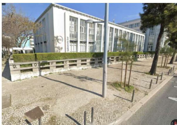
Fig.98. Fotografia do edifício da Standard Eléctrica através de uma pesquisa feita pela plataforma do google maps.
