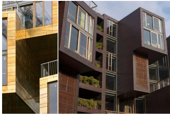
Fig.79. Detalhe para a observação dos revestimentos do edifício.
