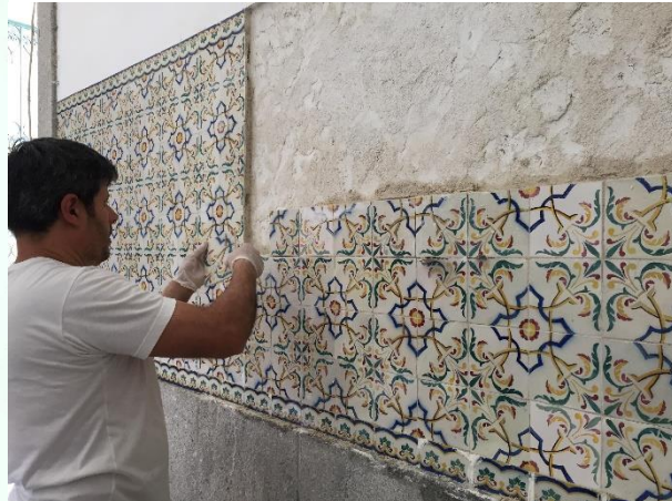
Figura 11 Reaplicação dos azulejos com recurso a argamassas compatíveis com o original. Autoria: Catarina Castelo
