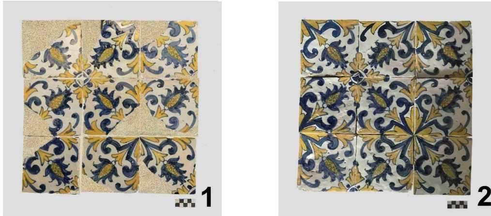
Figura 20 Painel de azulejo com preenchimento de argamassa de areia e cal (1) e painel de azulejo com reintegração mimética (2). Autoria: Catarina Castelo
