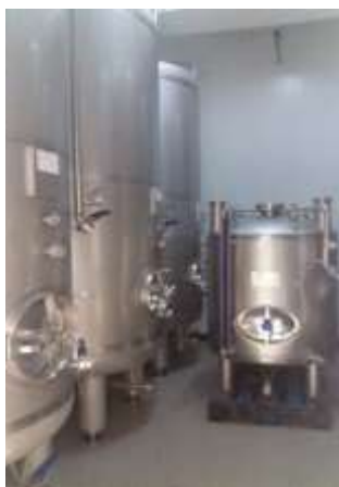
Figura 23 - Tanques de maturação (Santos, C.(2017))
