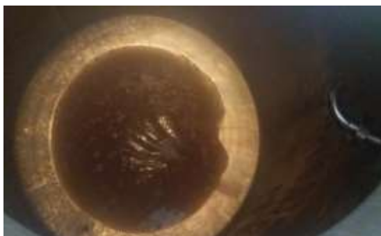
Figura 17 - Clarificação na caldeira de ebulição (Santos, C.(2017)
