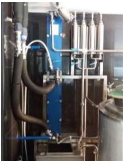
Figura 19 - Permutador de placas (em azul) e os tubos pretos são onde circula o glicol (Santos, C.(2017)
