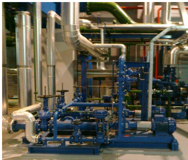
Figura 39 - Bombas de extracção de condensado
