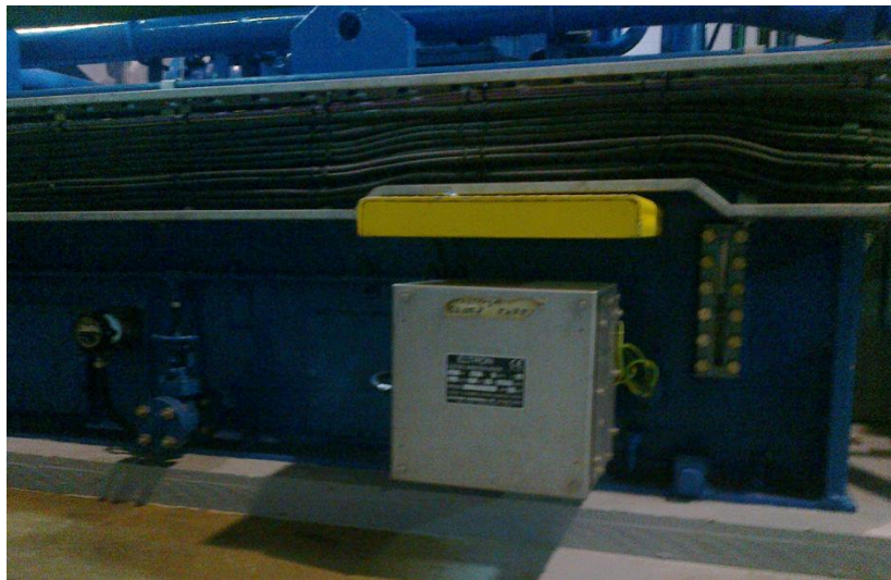
Figura 33 - Reservatório e nível de óleo
