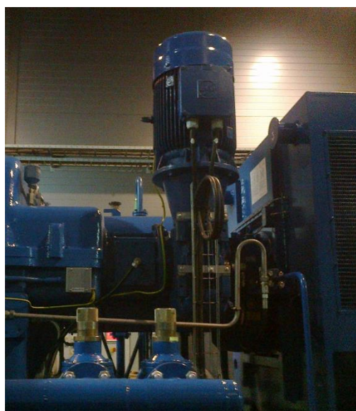
Figura 32 - Mecanismo de arranque auxiliar e motor
