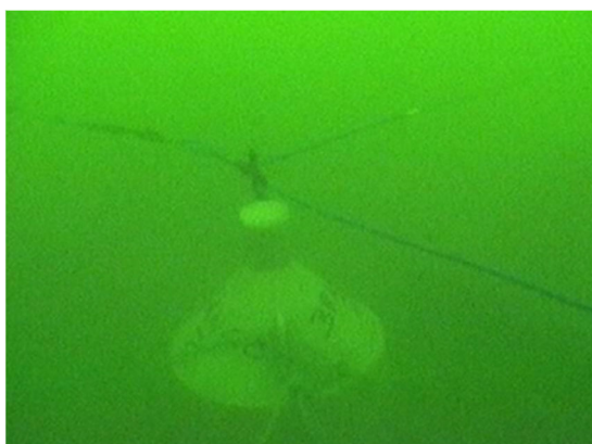
Foto E – Posicionamento sobre o fundo marinho das cargas explosivas.
