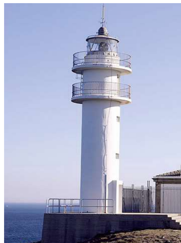
Fig.10 Fotografía de la torre
