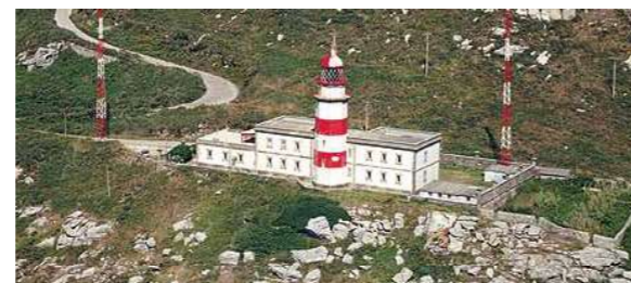
Fig.06 Fotografía lateral del conjunto del faro
