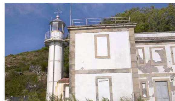
Fig.07 Fotografía del conjunto del faro
