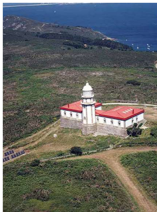
Fig.10 Fotografía de la torre
