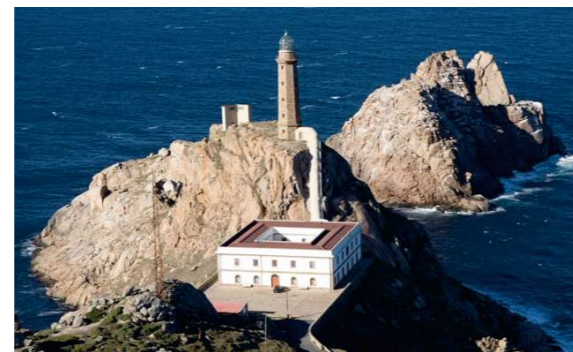
Fig.07 Fotografía del conjunto del faro
