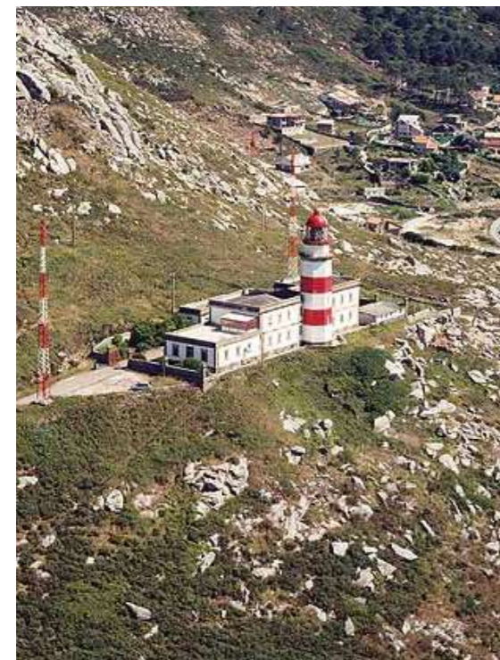
Fig.08 Fotografía de la torre
