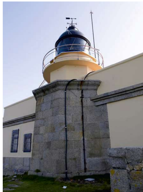
Fig.10 Fotografía de la torre
