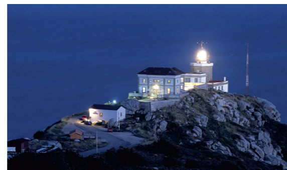
Fig.08 Fotografía del conjunto del faro
