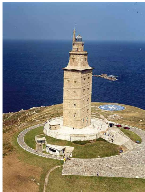
Fig.08 Fotografía de la torre
