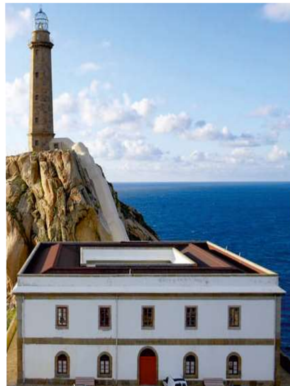
Fig.09 Fotografía de la torre
