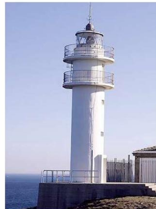
Fig.10 Fotografía de la torre
