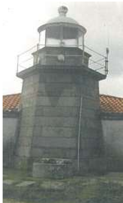
Fig.08 Fotografía de la torre
