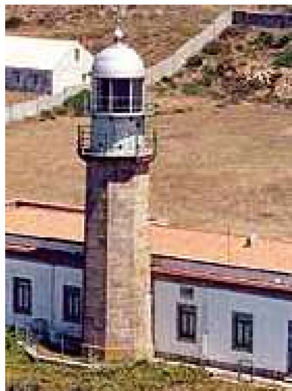
Fig.08-- Fotografía de la torre
