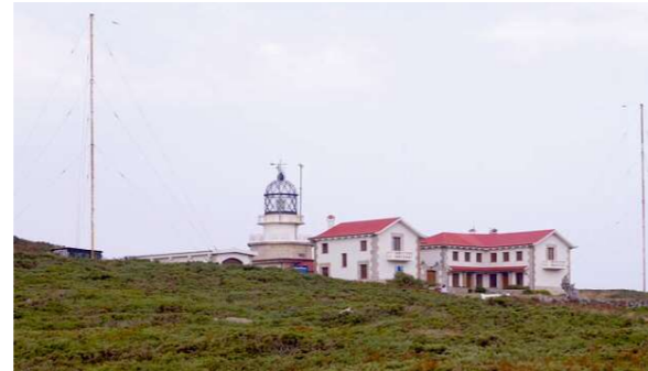
Fig.08 Fotografía lateral del conjunto del faro
