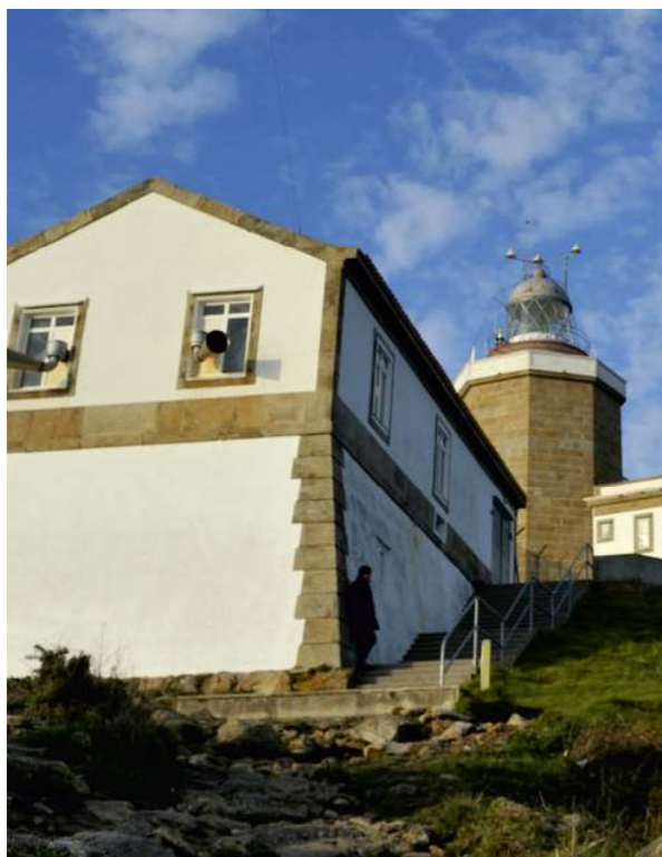
Fig.10 Fotografía lateral del conjunto y de la torre
