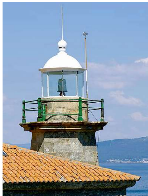
Fig.08 Fotografía de la torre
