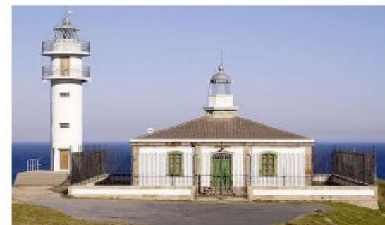
Fig.08 Fotografía de la fachada de entrada del faro
