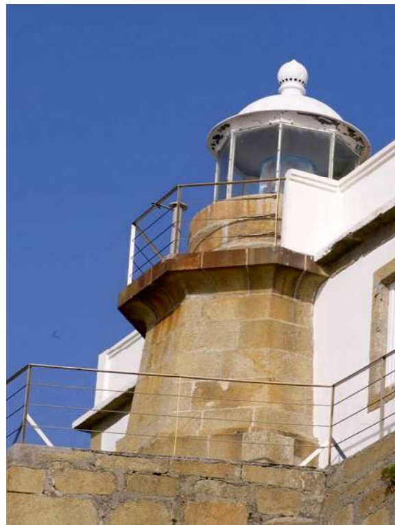
Fig.10 Fotografía de la torre
