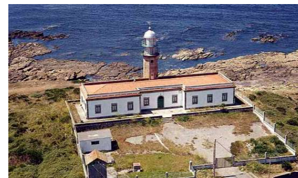
Fig.06 Fotografía del conjunto del faro
