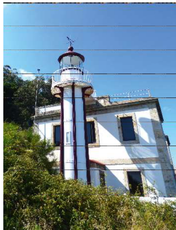
Fig.09 Fotografía de la torre
