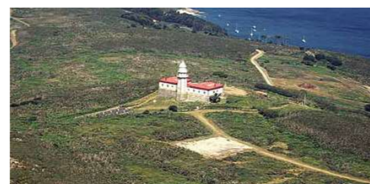
Fig.08 Fotografía lateral del conjunto del faro
