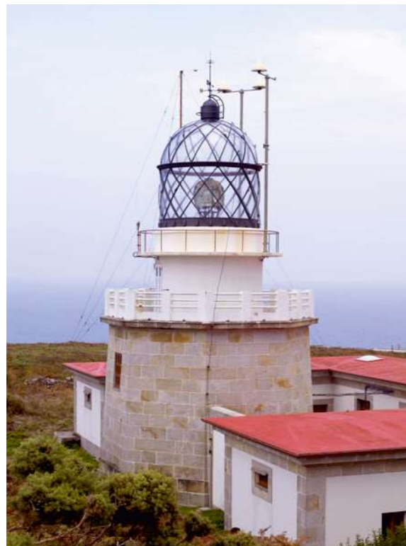
Fig.10 Fotografía de la torre
