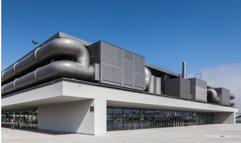
Figura 53: Fotografia do Pavilhão Multiusos de Viana
