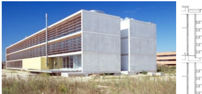
Figura 66-67: à esquerda uma Fotografia e à direita um Pormenor da Fachada do Departamento de Geociências
