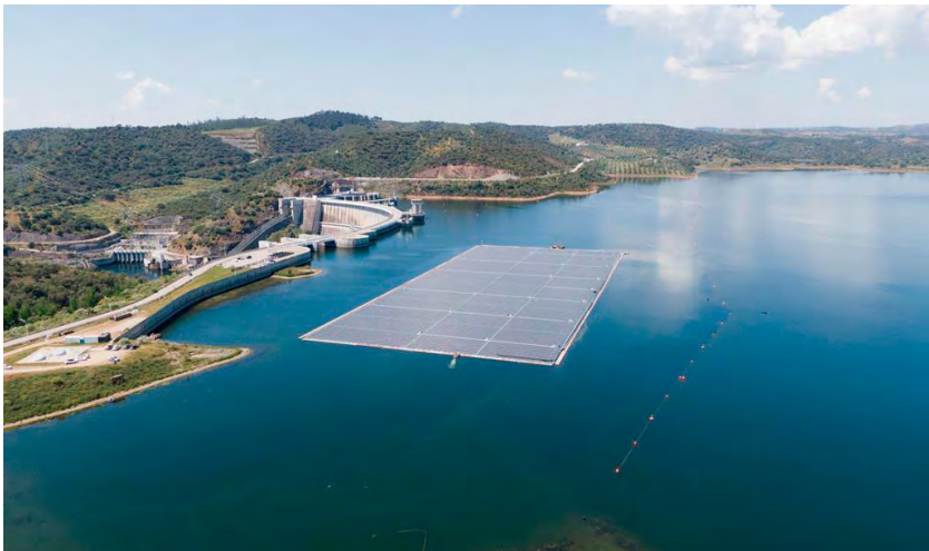
Figura 3. PV flutuante, Alqueva.
