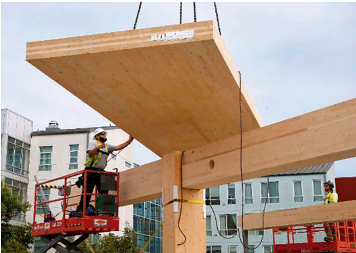
Figura 9. Imagem de uma laje de CLT, em colocação no edifício.
