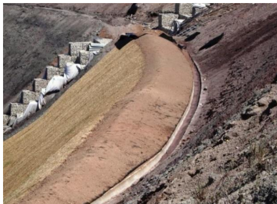
Figura 9 - Caso de obra no nó da A21, Malveira (Bifulco et al., 2016).
