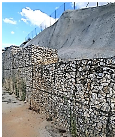
Figura 61 - Exemplo de estrutura de suporte: Gabiões, 2020
