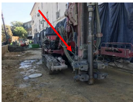
Figura 102 – Equipamento utilizado na técnica de jet-grouting a executar na crista da Encosta de Santa Margarida (Agosto, 2018)
