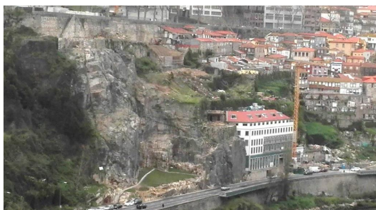
Figura 30 - Secção 3.1 após obras de estabilização (LNEC – NGEA, 392/2011)
