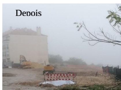
Figura 88 – Após a execução da demolição, outubro, 2019
