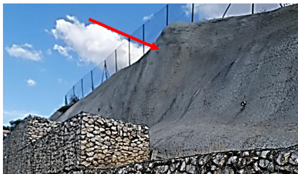
Figura 67 - Técnica de betão projetado em talude e aplicação de drenos profundos, Santarém, 2020
