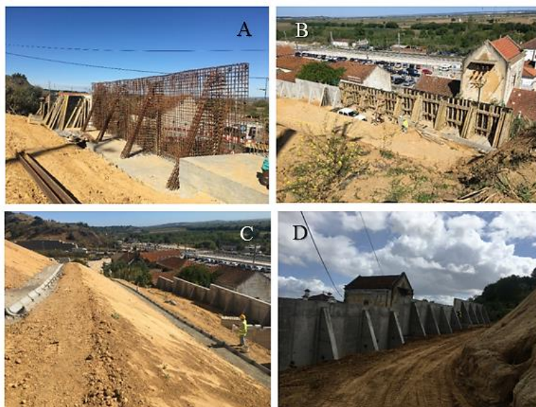
Figura 112 – Faseamento construtivo do muro de contenção em betão armado com contrafortes fundado em microestacas na Encosta da Ribeira de Santarém (Rioboco, Abril, 2019)
