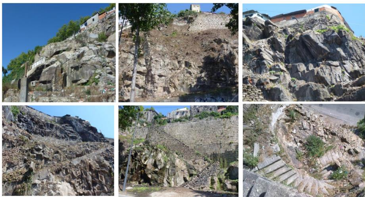
Figura 28 - Estado das escarpas nos setores 3 e 5 antes das obras de estabilização (LNEC – NGEA, 392/2011)
