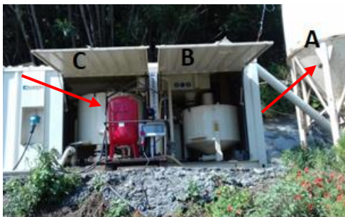
Figura 98 - A- Silo de cimento; B- Misturadora C- Bomba de argamassa, localizadas na Encosta de Santa Margarida (junho, 2018)
