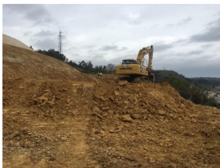
Figura 111 – Execução de movimento de terras na Encosta da Ribeira de Santarém (Rioboco, Abril, 2009)
