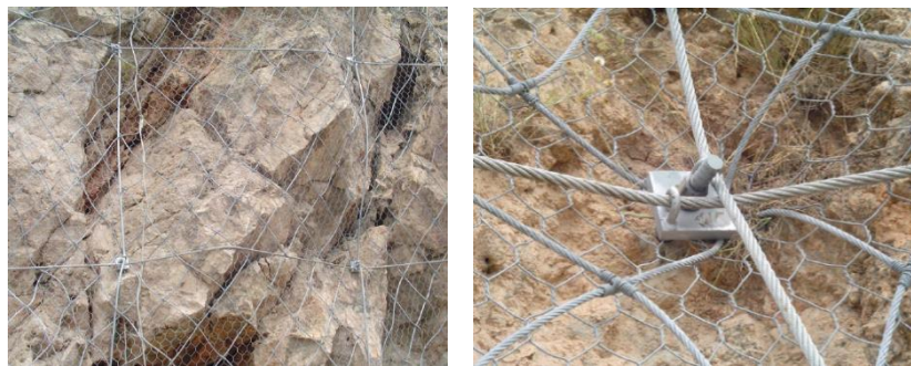
Figura 14 - Pregagens e malha reforçada (Coba, 2018)
