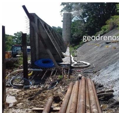
Figura 104 – Muro de suporte em betão armado com contrafortes e técnica de betão projetado e os dispositivos de drenagem, os geodrenos e os tubos manchete para execução das microestacas, aplicados na Encosta de Santa Margarida (junho, 2018)
