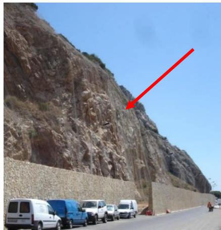
Figura 68 – Aplicação de redes metálicas na Serra da Arrábida (Coba, 2018)
