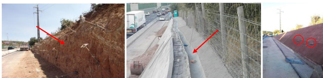
Figura 22 - Talude após demolição da capa de betão projetado, caleira de crista e geodrenos (LCW Consult, S.A., 2016)
