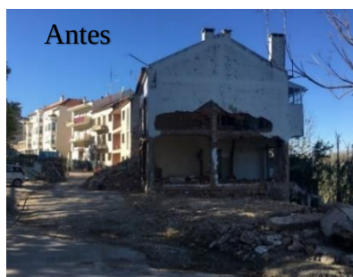
Figura 87- Edifícios existentes antes da execução da demolição na crista da Encosta de Santa Margarida (Rioboco, Março, 2019)
