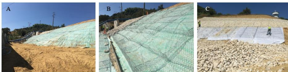
Figura 113 – Proteção superficial do talude, a partir da técnica de colchão reno, realizada na Encosta da Ribeira de Santarém (Fonte: Rioboco, Abril, 2019)
