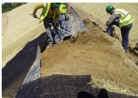
Figura 7 - Instalação da almofada de terra viva da banquetta viva "a Portuguesa" (Bifulco et al., 2016).
