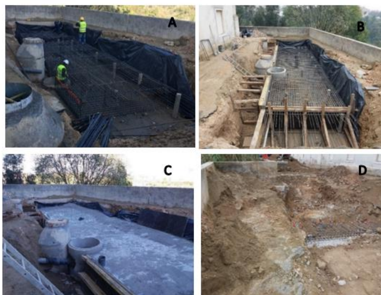
Figura 106 - Sequência construtiva da sapata de encabeçamento armada na crista da Encosta de Santa Margarida (Rioboco, Novembro, 2018)
