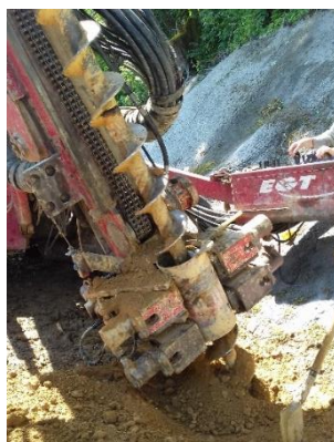
Figura 103 – Equipamento de furação por roto-percussão utilizado na técnica de jet-grouting a executar na Encosta de Santa Margarida (junho, 2018)
