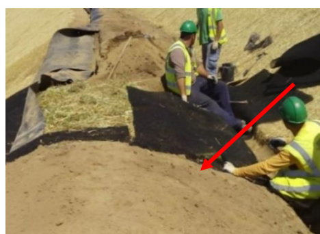
Figura 8 - A instalação das tiras da geogrelha em cima da almofada de terra viva (Bifulco et al., 2016).
