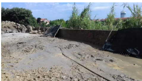
Figura 100 - Refluxo da calda de cimento: Técnica de Jet-grouting na crista da Encosta de Santa Margarida (junho, 2018)
