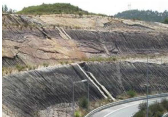
Figura 1 - Perspetiva geral do talude de escavação no nó da Malveira (sentido A8-Malveira) (Bifulco et al., 2016)
