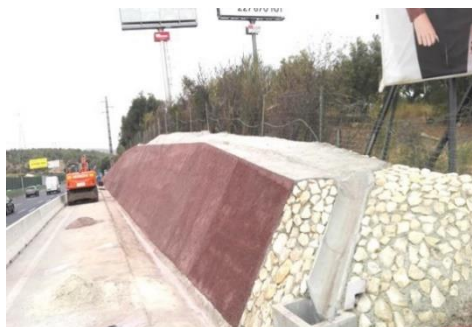
Figura 23 - Aspeto final da solução do muro de suporte (LCW Consult, S.A., 2016)
