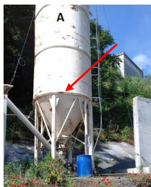
Figura 99 - Silo de cimento localizado na Encosta de Santa Margarida (junho, 2018)
