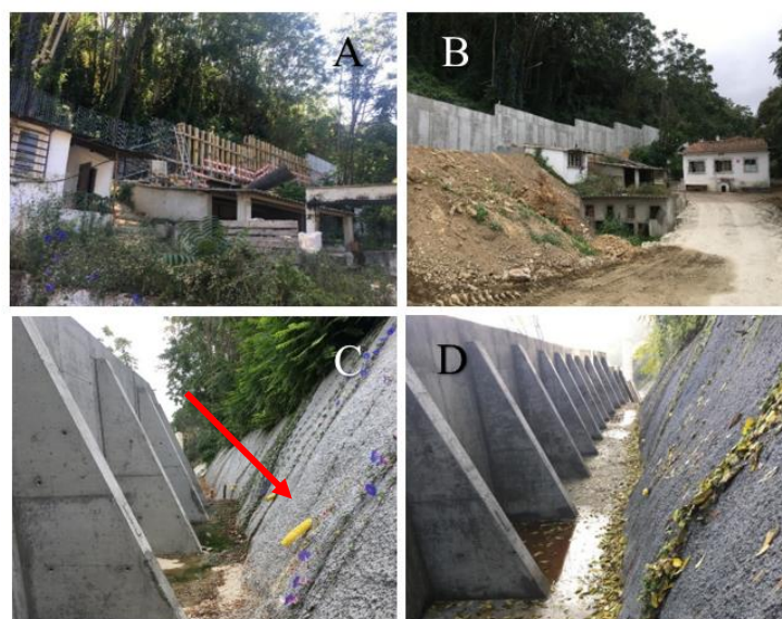
Figura 107 - Muro de suporte em betão armado com contrafortes fundado por microestacas e técnica de betão projetado e os dispositivos de drenagem, os geodrenos aplicados na Encosta de Santa Margarida (Novembro, 2018)
