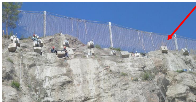
Figura 15 – Ancoragem de blocos rochosos (Coba, 2018)
