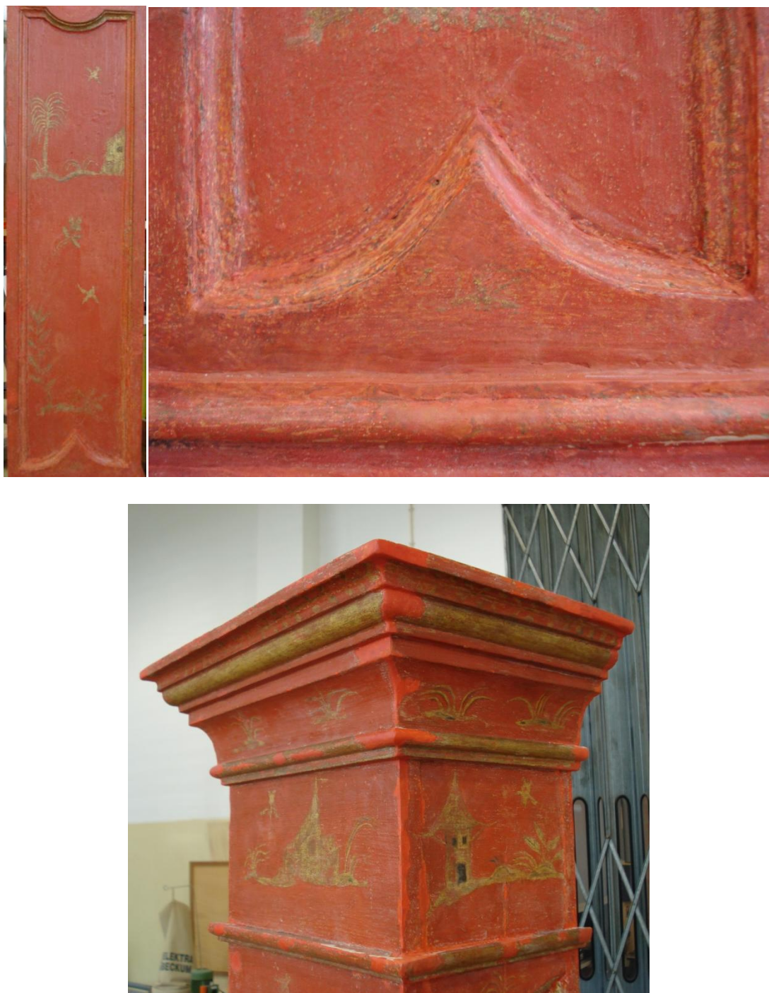
Figura 54. Começo da fase de reintegração cromática, mimética, através do preenchimento com tinta acrílica nas áreas de lacunas de cor vermelho-alaranjado 14 .
