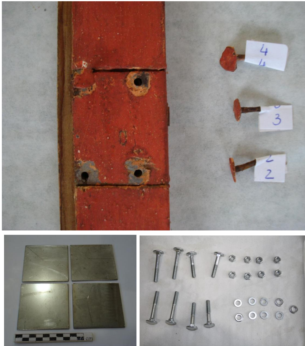
Figura 52. Remoção dos elementos metálicos da fechadura da porta da caixa superior, para limpeza e protecção do metal (em cima). Elementos metálicos novos, adossados ao conjunto dos elementos da caixa de relógio. As chapas em inox foram encomendadas para, após executar os furos para os novos parafusos com brocas de 9 e 10 mm, serem colocadas no alçado inferior da caixa de relógio e fazer a ligação dos frisos e da estrutura do corpo inferior. 12
