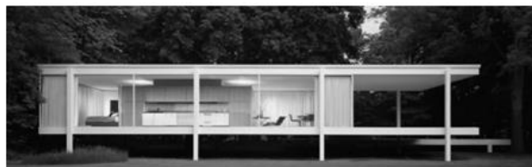
FIG. 16 - Mies van der Rohe, Farnsworth House, 1946
