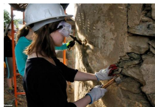
Fig. 72 | Remoção do revestimento exterior
