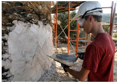
Fig. 74 | Colocação de revestimento exterior
