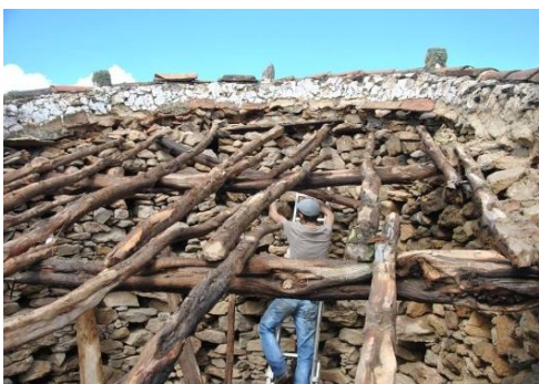
Fig. 75 | Recuperação de cobertura em madeira
