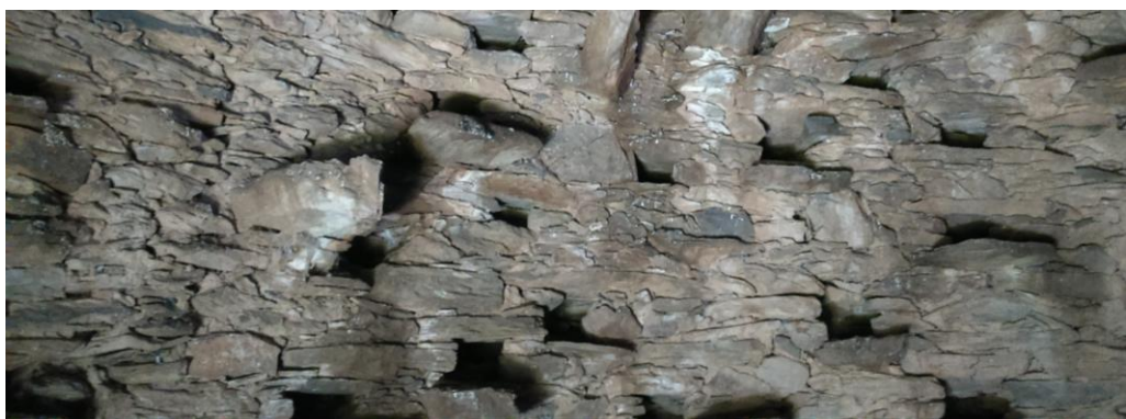
Fig. 41 | Parede interior de um pombal
