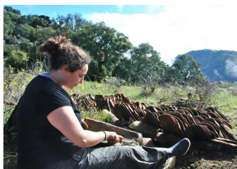
Fig. 76 | Limpeza e recuperação de telha cerâmica
