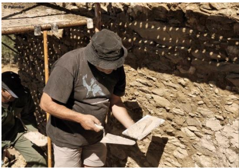
Fig. 73 | Reparação de paredes exteriores
