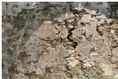
Fig. 51 | Reboco (pombal por recuperar)
