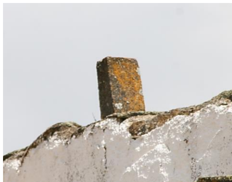
Fig. 61 | Pináculo de tijolo maciço
