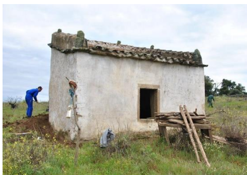
Fig. 71 | Desmatação e limpeza do local
