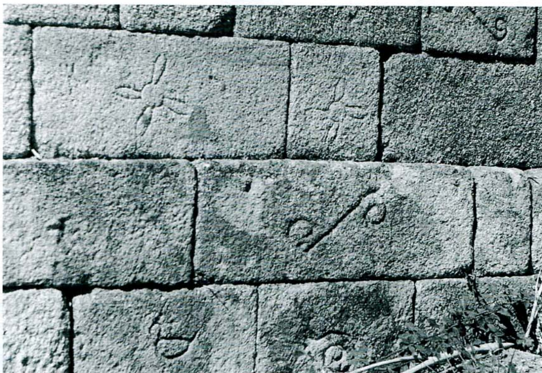
Foto 7 – Marcas de canteiro numa das paredes da Igreja de Santa Maria (intra-muros do Castelo de Numão)
