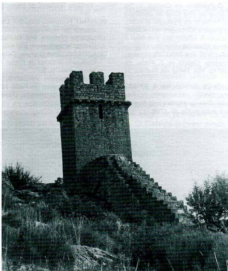
Foto 4 – Uma das poucas torres (das 15 que já teve!) que ainda se mantêm em pé no Castelo de Numão
