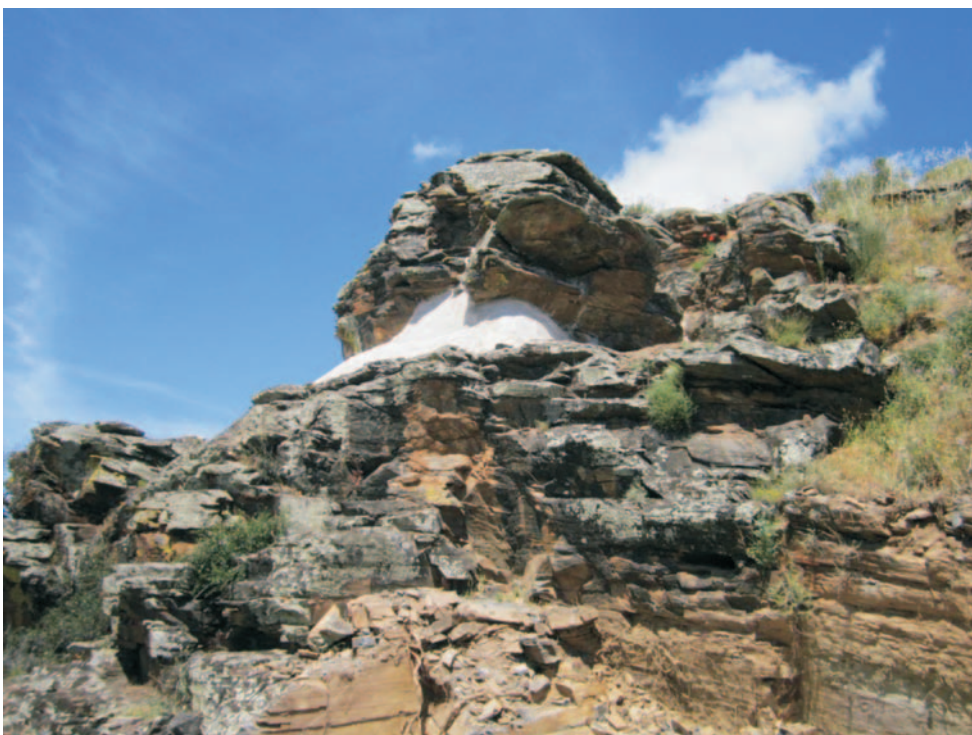
Figura 4: Aspeto do maciço rochoso EP215 após execução do projeto de preservação in situ.
