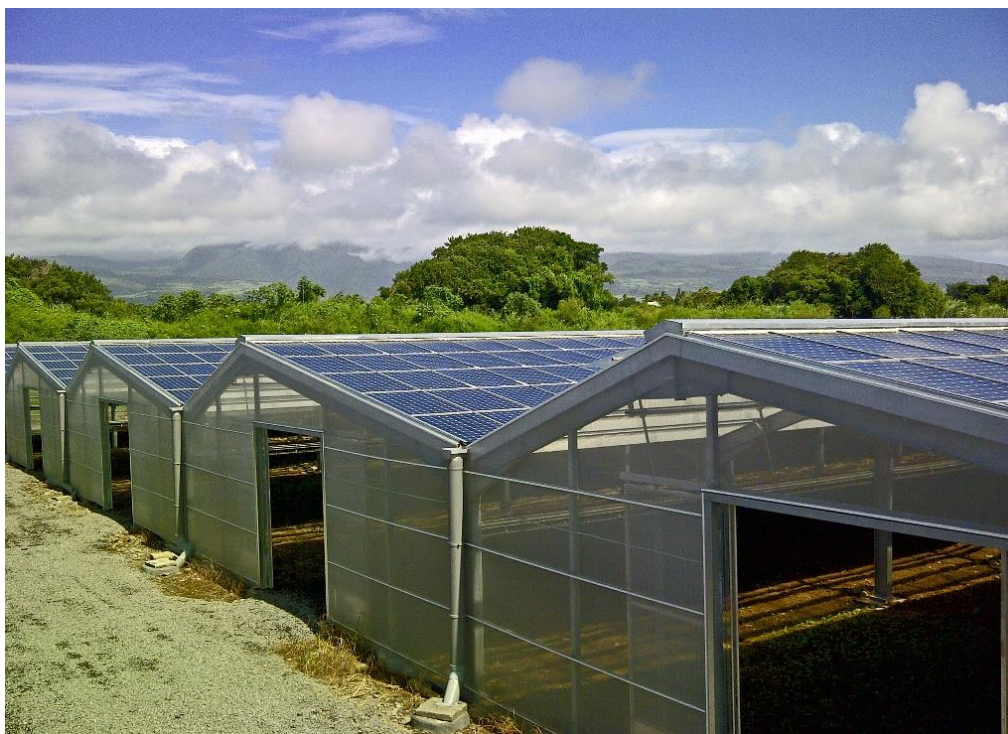
Figura 2.3. Exemplo da aplicação de uma estufa fotovoltaica.
