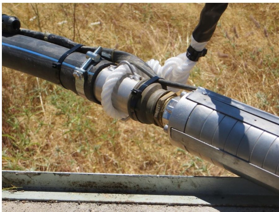
Figura 4.20. Reparação do sistema de bombagem solar.
