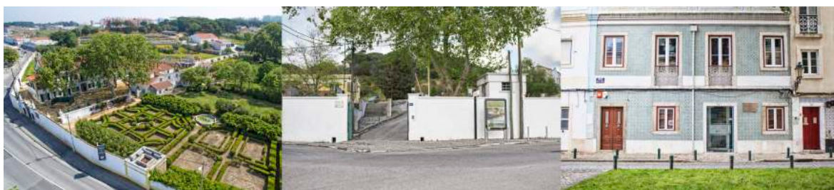
Figura 43 – Fachadas dos espaços a intrevencionar. Fonte: Foto de autor
