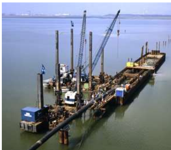
Figura 3 - Empreitada do Gasoduto de Transporte de Gás Natural entre Sines e Setúbal, Seth, S.A. (Fonte: www.seth.pt )
