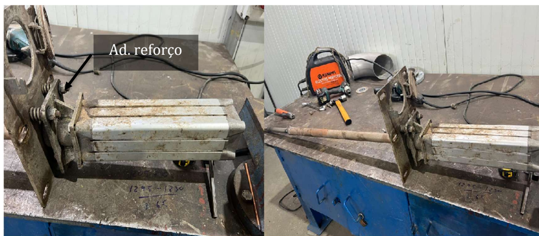
Figura 5.17 – Melhorias implementadas nos sopradores da unidade funcional de fornecimento de ar.
