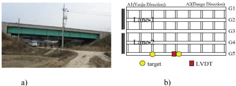
Figura 2.7 - Viaduto Samseung e posição de alvos monitorizados (Kim e Kim, 2011)
