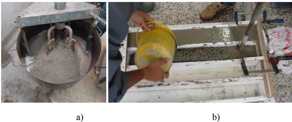
Figura 4.3 - Constituintes na misturadora; betonagem e vibração do betão na cofragem
