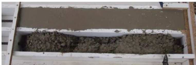
Figura 4.4 – Pormenor do betão na cofragem
