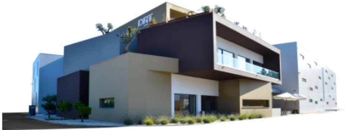
Figura 1 - Instalações DRT GROUP
