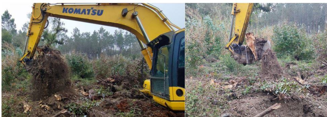
Figura 1 Destroçamento/arranque de cepos com uma giratória equipada com enxó
