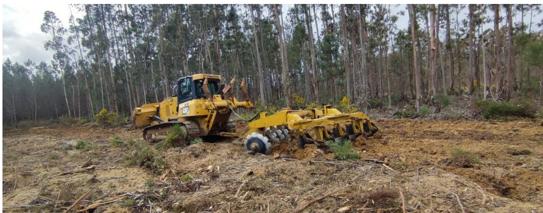
Figura 2 Gradagem com Bulldozer acoplada com grade de discos pesada
