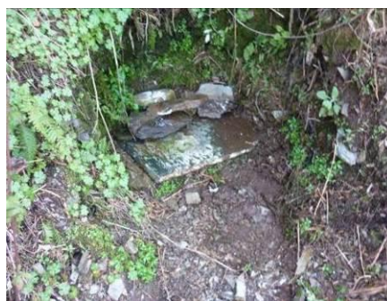
Figura 145 – Área envolvente da nascente do Sistema de Abastecimento de Mourísia e infraestrutura em betão e laje de xisto a servir de tampa.
