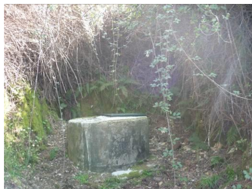
Figura 100 – Área envolvente da mina 2 do Sistema de Abastecimento de Moura da Serra.
