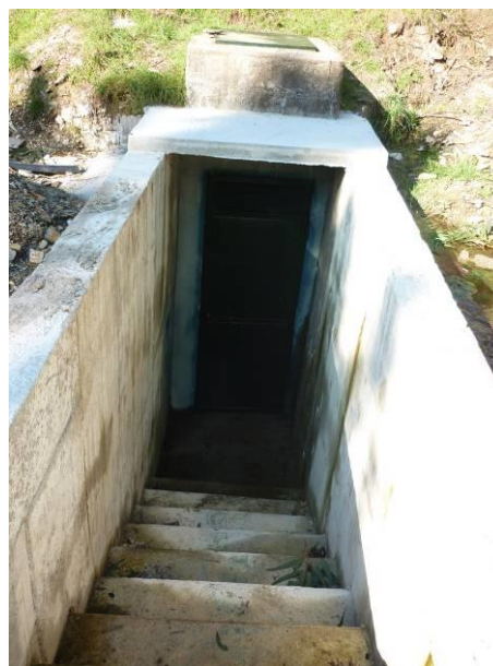
Figura 123 – Acesso para a entrada da Mina 1 do sistema de abastecimento de Dreia.
