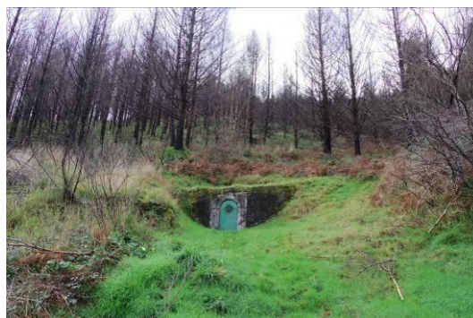
Figura 43 – Área envolvente da captação (Mina 2) do Sistema de Abastecimento de Lomba.
