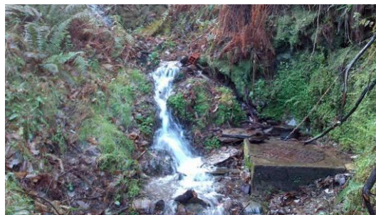
Figura 21 – Área envolvente da captação (Nascente) do Sistema de Abastecimento de Alqueve.
