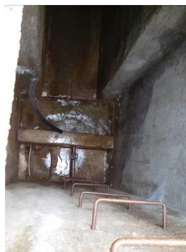
Figura 81 – Caixa de receção de água oriunda da mina e da nascente 1 localizada numa cota superior.
