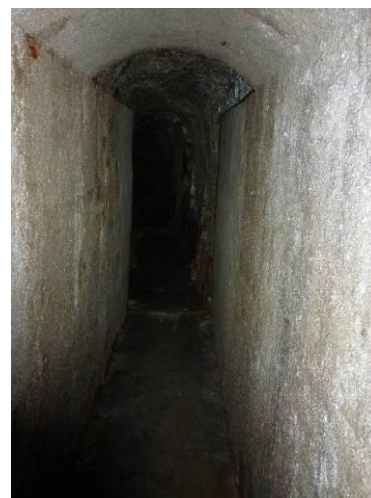
Figura 152 – Entrada para a galeria da mina rebocada a cimento e dentro da mina paredes de xisto.
