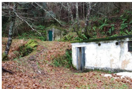
Figura 53 – Área envolvente da captação (Nascente) do Sistema de Abastecimento de Lomba.
