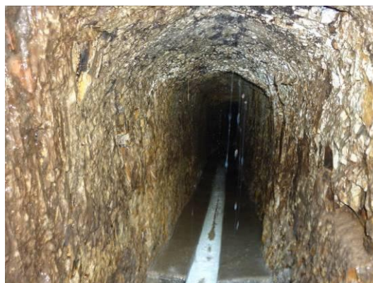
Figura 124 – Galeria da Mina 1 com paredes em xisto.
