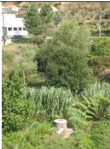
Figura 12 – Área envolvente da captação (Poço) do Sistema de Abastecimento de Pomares.
