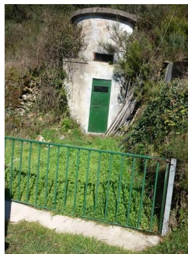
Figura 34 – Área envolvente da captação (Mina) do Sistema de Abastecimento de Monte Frio e vedação.
