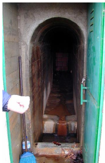
Figura 139 – Acesso para a galeria da Mina 1.
