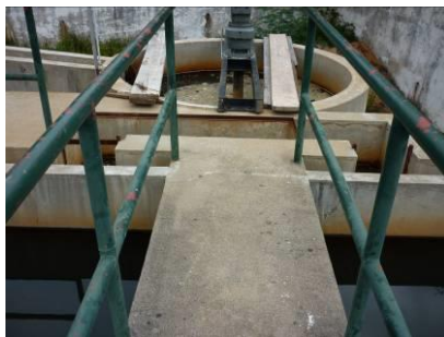
Figura 33 – Secção de passagem da água do agitador para os tanques de sedimentação.
