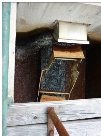
Figura 36 – Queda de água de um decantador para um dos tanques com filtros de areia.
