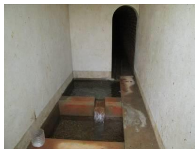
Figura 182 – Caixas de receção da água vinda da mina e entrada para a galeria da mina.
