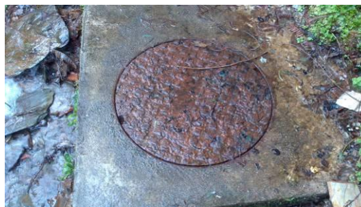
Figura 22 – Infraestrutura de proteção em betão com tampa em ferro fundido da nascente.
