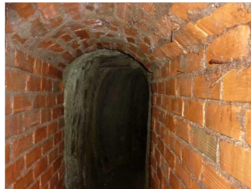
Figura 97 – Entrada da galeria da mina em tijolo.
