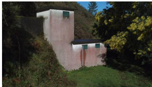
Figura 25 – Infraestrutura de proteção da mina e estação de tratamento do Sistema de Abastecimento de Alqueve.
