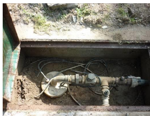
Figura 93 – Furo e respetiva tubagem proveniente do furo.
