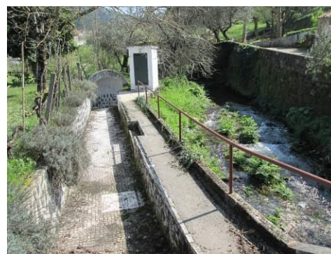
Figura 197 – Área envolvente da captação e estrutura onde se armazena a água e onde é tratada.
