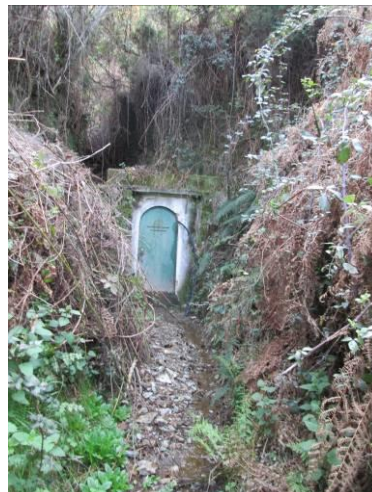
Figura 192 – Área envolvente e infraestrutura de proteção com porta metálica com fechadura da mina do Sistema de Abastecimento de Adcasal.
