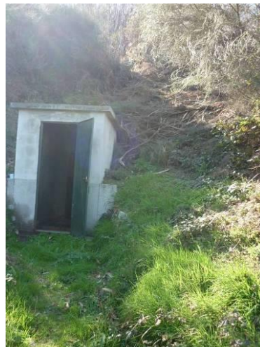
Figura 150 – Área envolvente da captação (Mina) do Sistema de Abastecimento de Valado.
