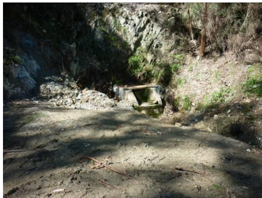
Figura 134 – Área envolvente da captação (Nascente) do Sistema de Abastecimento de Barrigueiro.
