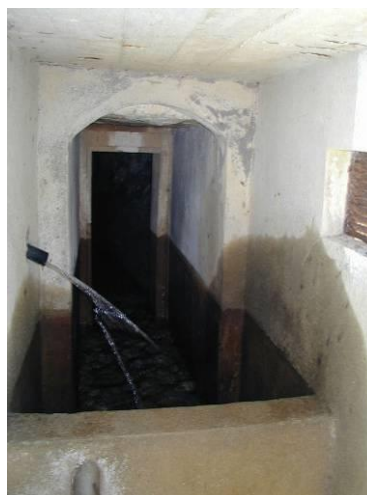
Figura 85 – Caixa de receção da água vinda da mina e da nascente localizada numa cota superior.
