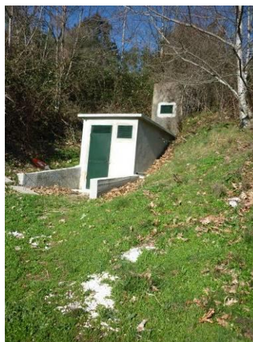
Figura 126 – Área envolvente da captação (Mina 2) do Sistema de Abastecimento de Dreia.
