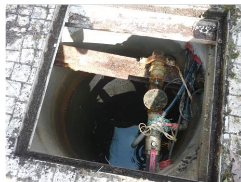
Figura 199 – Interior do poço.
