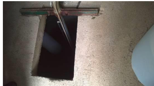
Figura 18 – Captação de água: Poço do Mosteiro de Folques.
