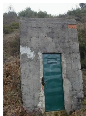
Figura 119 – Área envolvente e infraestrutura de proteção com porta metálica para a entrada de uma das minas (3).
