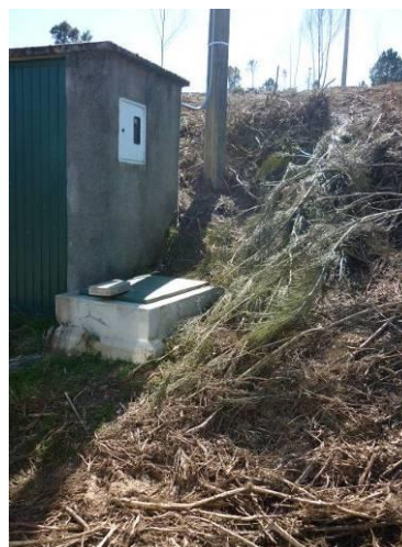
Figura 30 – Área envolvente da Infraestrutura de proteção da captação (Furo) do Sistema de Abastecimento de Monte Frio.
