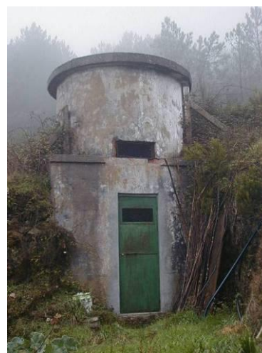
Figura 35 – Infraestrutura de proteção em betão com porta metálica com fechadura da mina.
