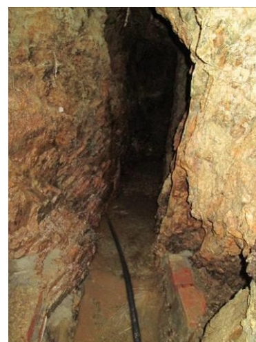
Figura 190 – Galeria da mina da captação.
