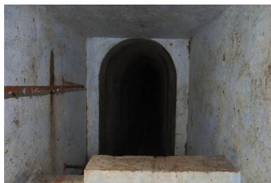
Figura 40 – Entrada da galeria da mina 1.
