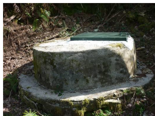
Figura 96 – Infraestrutura de proteção e acesso da mina 1 do Sistema de Abastecimento de Moura da Serra.
