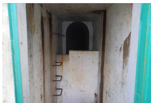
Figura 39 – Zona interior da infraestrutura de proteção da mina 1.
