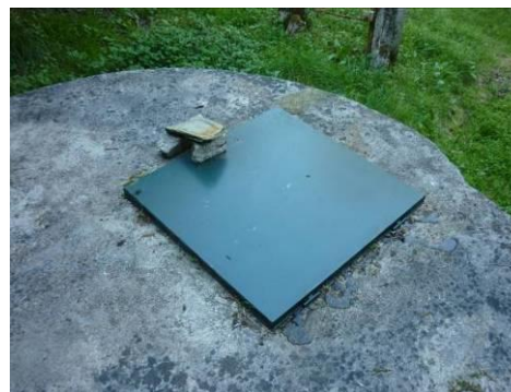
Figura 156 – Parte superior da infraestrutura de proteção com tampa metálica e cadeado da mina.
