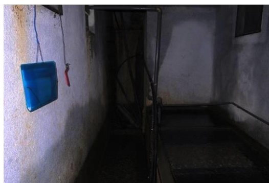
Figura 26 – Acesso para entrada da galeria da mina e caixas do tratamento de água.
