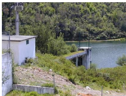
Figura 19 – Poço na margem do rio onde a água é captada.
