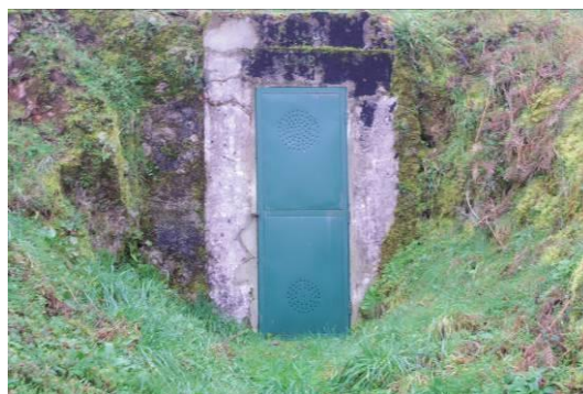
Figura 38 – Área envolvente da captação (Mina 1) do Sistema de Abastecimento de Lomba.
