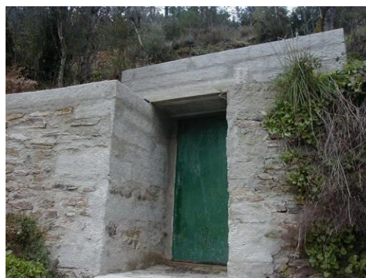
Figura 189 – Infraestrutura de proteção da Mina com porta metálica fechada a chave.
