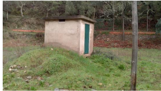
Figura 16 – Área envolvente da captação (Poço) do Sistema de Abastecimento de Alqueve.
