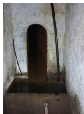
Figura 148 – Entrada da galeria da mina e caixa de receção da água proveniente da mina e da nascente encontrada numa cota superior.
