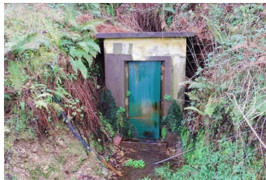
Figura 206 – Infraestrutura de proteção da Mina.
