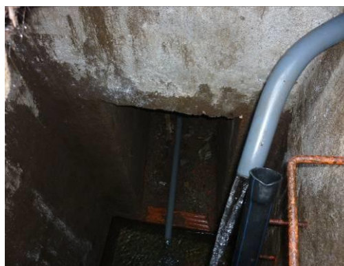
Figura 176 – Infraestrutura de proteção com tampa em ferro fundido da captação.
