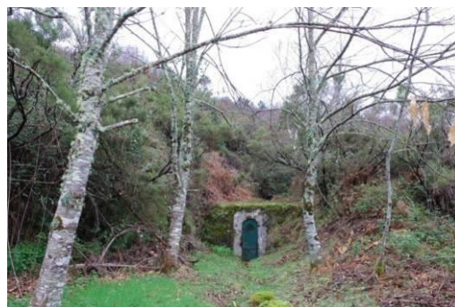
Figura 58 – Área envolvente da captação (Mina 1) do Sistema de Abastecimento de Nogueira.
