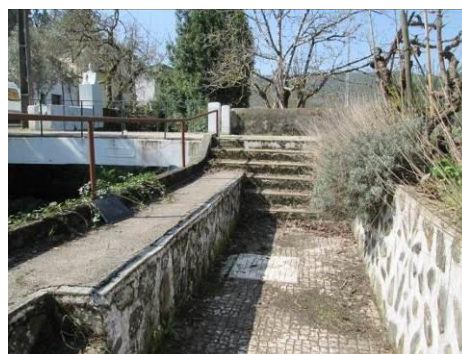
Figura 196 – Área envolvente do poço do Sistema de Abastecimento de Celavisa.
