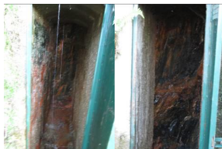
Figura 118 – Entradas para as galerias de duas das minas (1 e 2).
