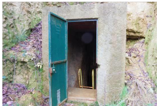
Figura 142 – Acesso de entrada para a galeria da Mina 2.
