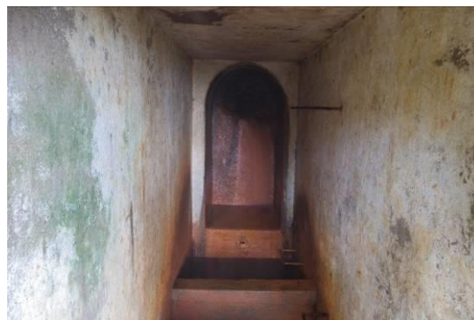
Figura 55 – Interior da infraestrutura da captação.
