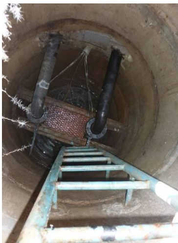
Figura 14 – Interior do poço revestido a betão manilhado.
