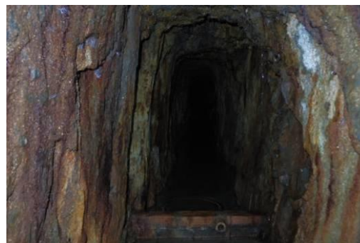
Figura 64 – Galeria da Mina 2.
