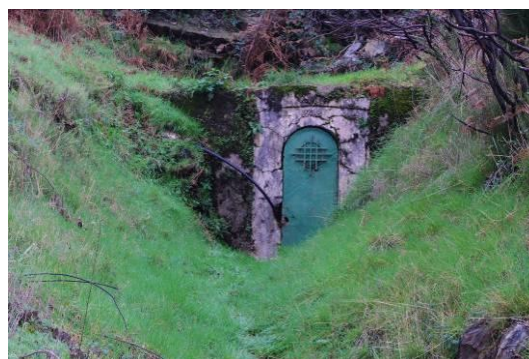
Figura 49 – Infra-estrutura de proteção e porta de entrada para a Mina 3.
