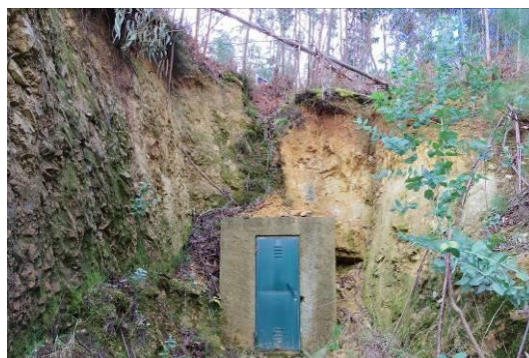
Figura 141 – Área envolvente da Mina 2 do Sistema de Abastecimento de Valbona.
