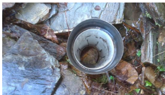
Figura 23 – Dreno da captação de Alqueve.
