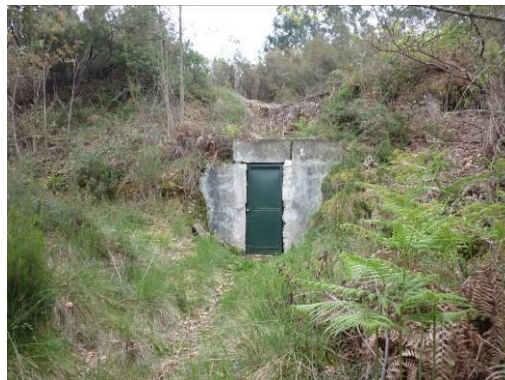
Figura 167 – Área envolvente e entrada para a Nascente do Sistema de Abastecimento de Bufalhão.
