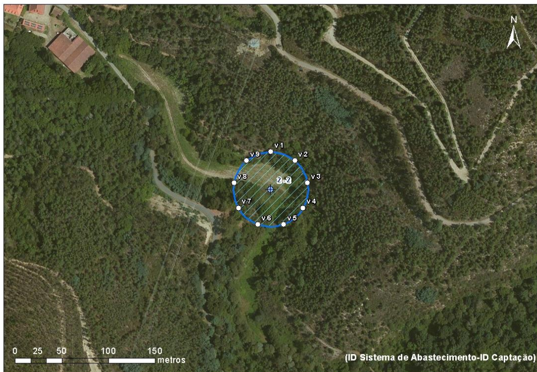
Figura 20 – Zona de proteção imediata do Poço do Mosteiro de Folques do Sistema de Abastecimento de Alqueve.
