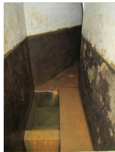
Figura 194 – Caixas de receção da água vinda da mina.
