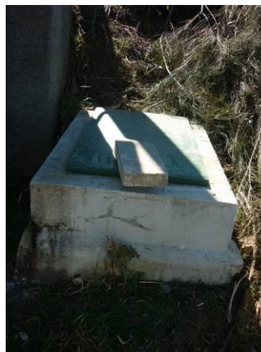
Figura 31 – Infraestrutura de proteção em betão com tampa metálica fechada a cadeado do furo.
