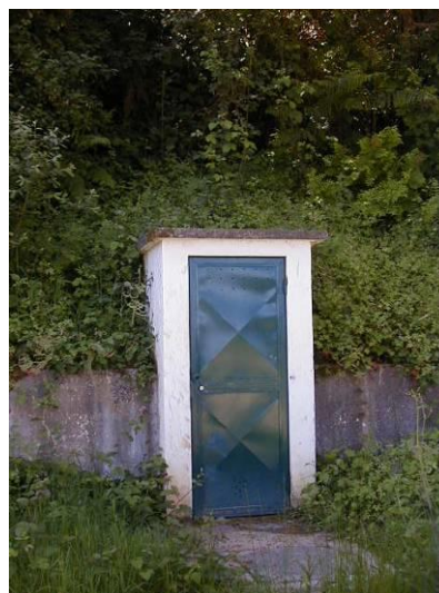
Figura 138 – Entrada com porta metálica para a Mina 1 do Sistema da Abastecimento de Valbona.
