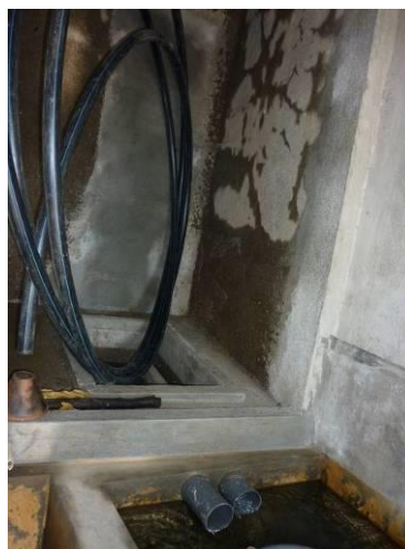
Figura 127 – Entrada para a galeria da Mina 2 tapada com cimento e saída da água da mina por tubo em PVC.
