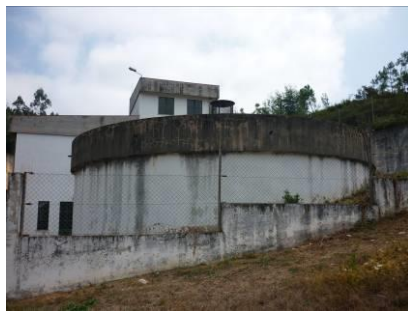
Figura 15 – ETA do Feijoal e reservatório de água.
