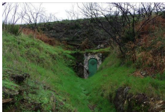
Figura 48 – Área envolvente da captação (Mina 3) do Sistema de Abastecimento de Lomba.
