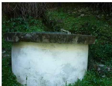
Figura 155 – Infraestrutura de proteção da captação em betão.
