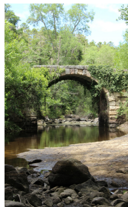
Ponte do Arquinho, Valpaços Fontel elaborada pelo autor;
