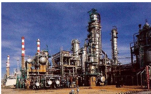
Figura 3.13 – Desasfaltação pelo Propano.
