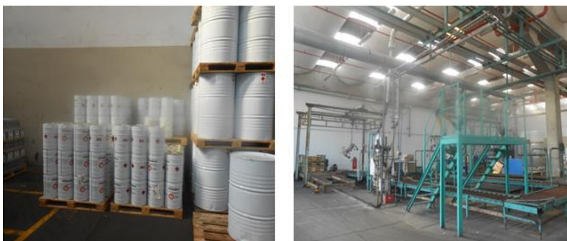
Figura 3.29 – Zona de enchimento e armazenamento de petróleos.
