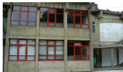
Figura 13 – Escola Secundária Garcia de Orta, antes da intervenção do programa “Parque Escolar”
