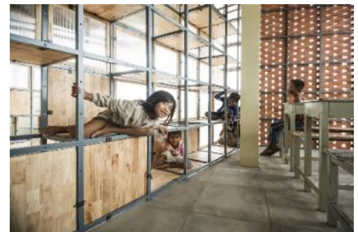
Figura 42 - Adventuorous Global School, estrutura metálica.
