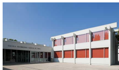
Figura 14 – Escola Secundária Garcia de Orta, antes da intervenção do programa “Parque Escolar”
