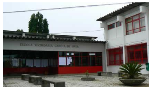
Figura 12 – Escola Secundária Garcia de Orta, antes da intervenção do programa “Parque Escolar”
