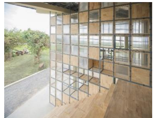
Figura 43 - Adventuorous Global School, estrutura metálica.
