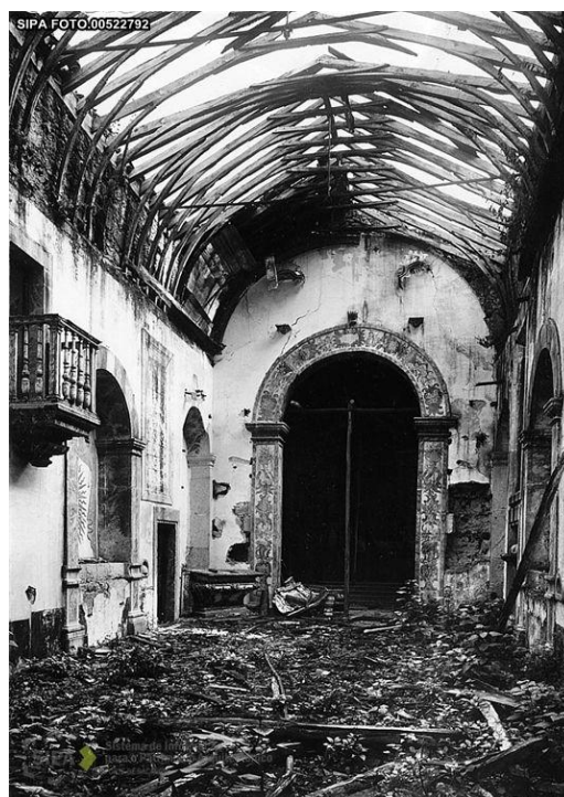
Figura 47 – Imagem antiga da cobertura
