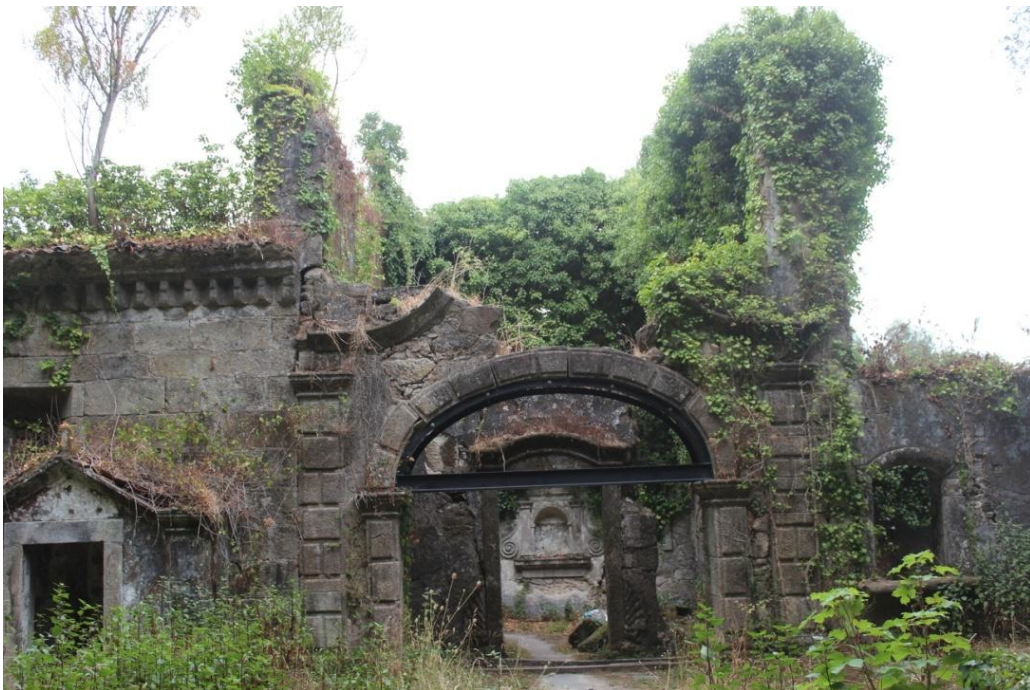
Figura 14 – Imagem da intervenção atual do arco central da portaria
