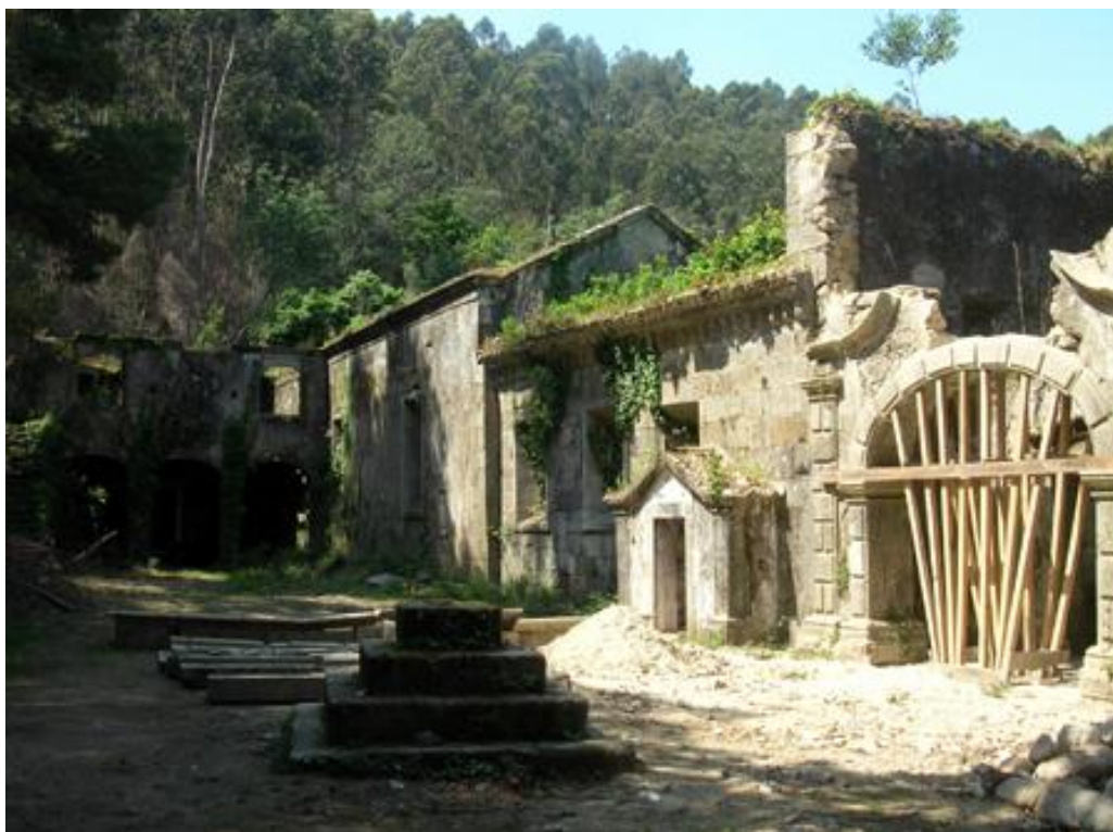
Figura 81 –Imagem da intervenção do arco central da portaria
