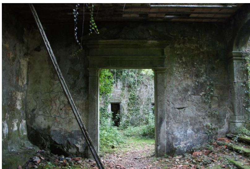
Figura 43 – Estado Portal Axial atualmente
