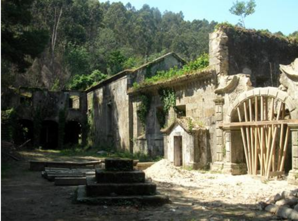
Figura 13 –Imagem da intervenção do arco central da portaria
