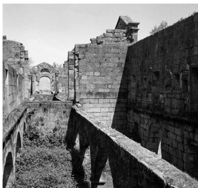
Figura 97 – Estado de ruína do Convento
