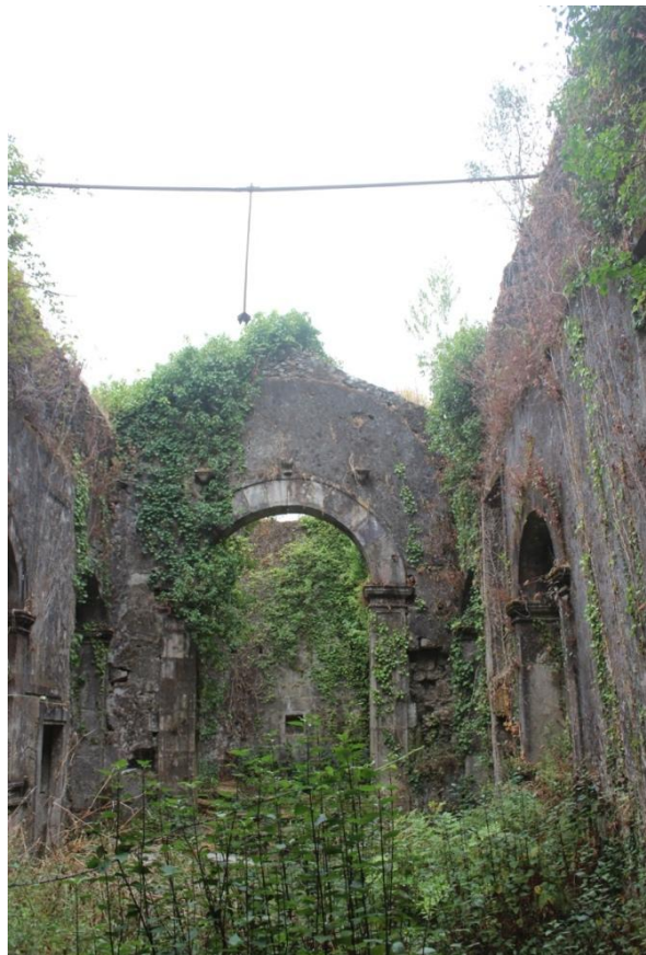
Figura 53 – Estado da Capela, atualmente
