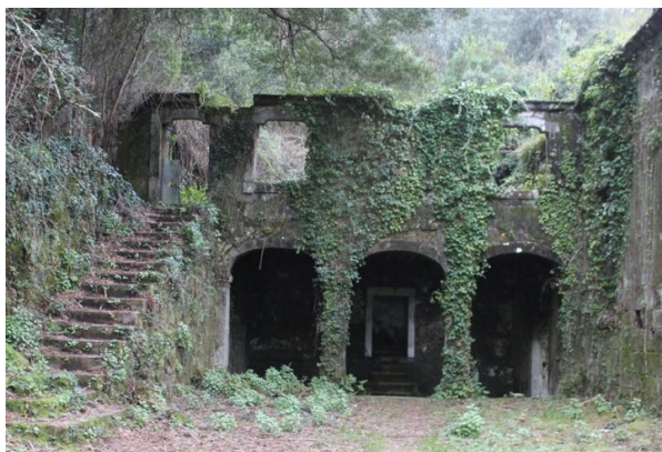
Figura 39 – Estado da Galilé atualmente
