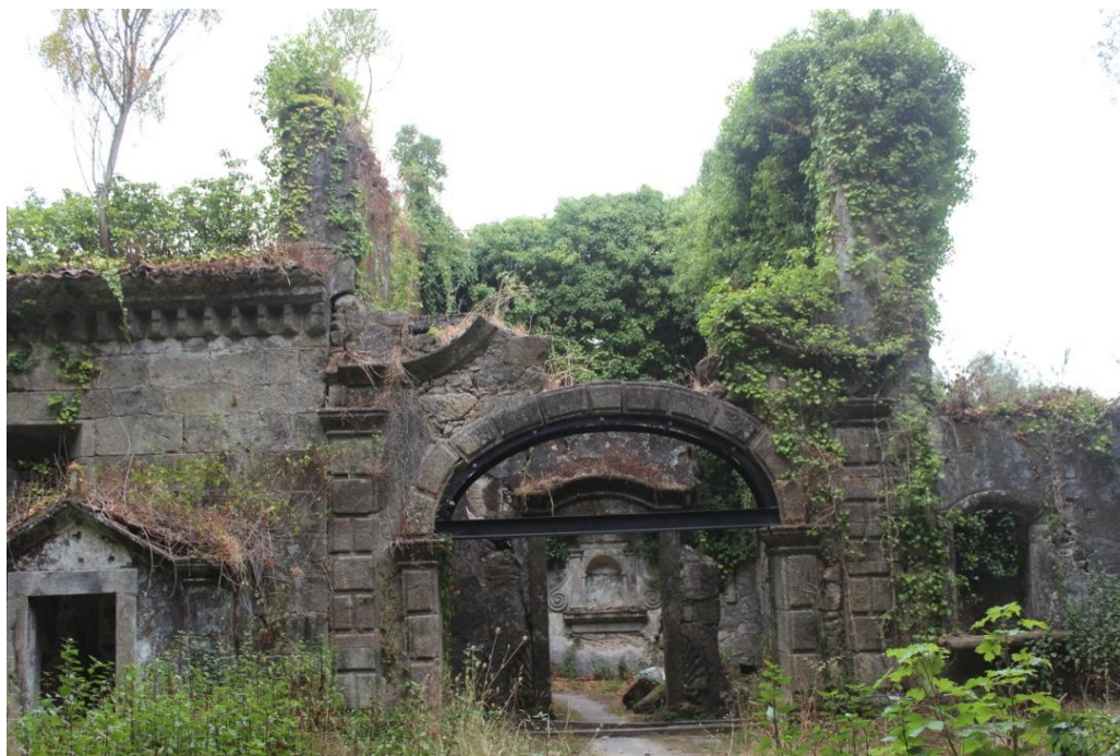
Figura 82 – Imagem da intervenção atual do arco central da portaria
