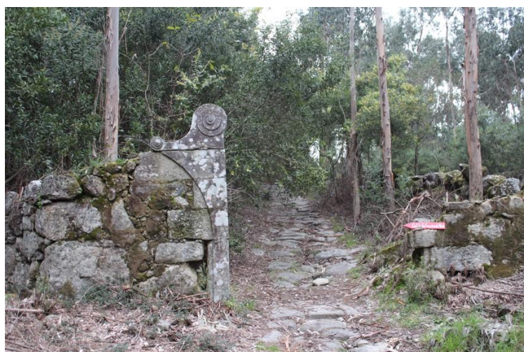
Figura 19 – Portão de entrada da via ascendente (1)
