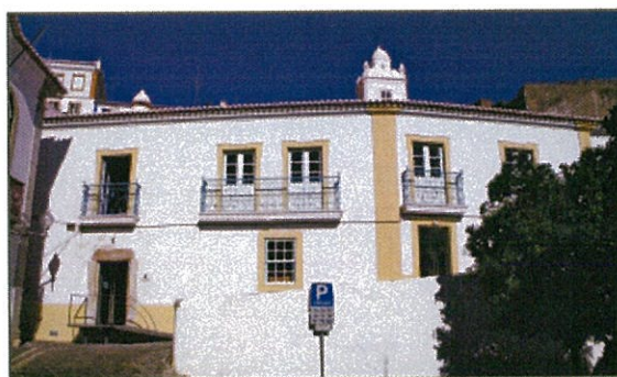
Fig. 1 – Casa do Lanternim (Mértola)
