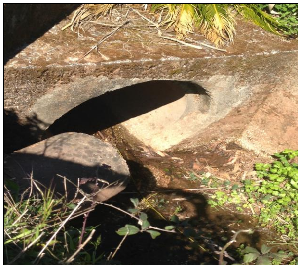
FIGURA 23. Coletor DN 900 mm identificado na secção S7.
