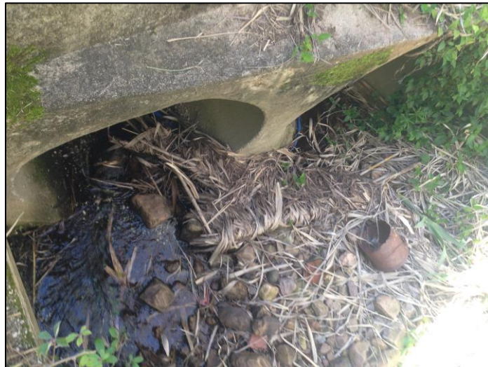
FIGURA 24. Coletor DN 2x1000 mm identificado na secção S8.
