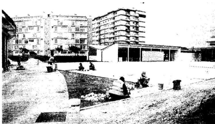
Trabalhos de requalificação do Mercado Municipal de Ovar estão quase concluídos, e o equipamento vai abrir dentro de dias
