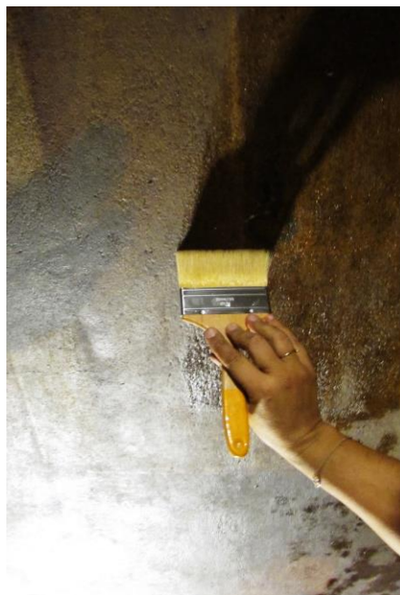
Figura 99. Aplicação de um filme de proteção sobre a superfície reintegrada.
