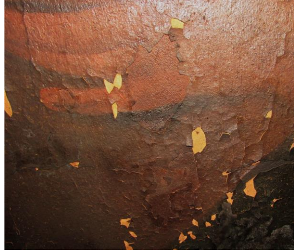
Figura 60. Reintegrações cromáticas executadas diretamente sobre o estrato correspondente ao reboco.
