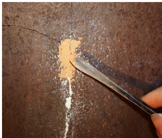
Figura 96. Preenchimento de uma fissura com Modostuc® Douglas.
