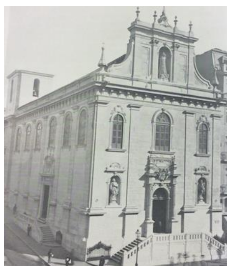
Figura 11. Portal decorativo da fachada da igreja (SEQUEIRA, 1942).
