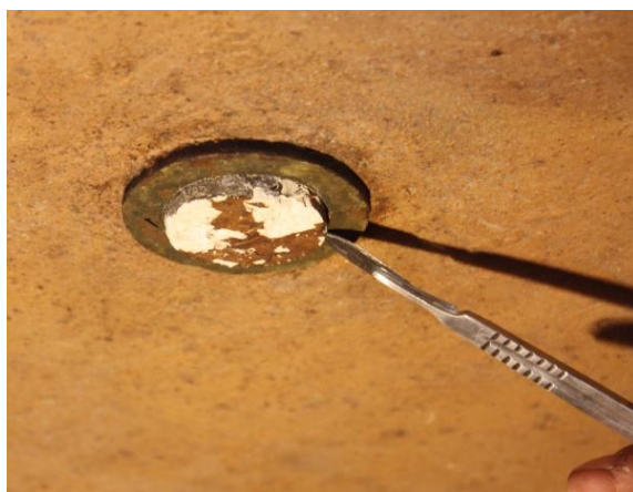
Figura 91. Remoção da massa de preenchimento da peça metálica.
