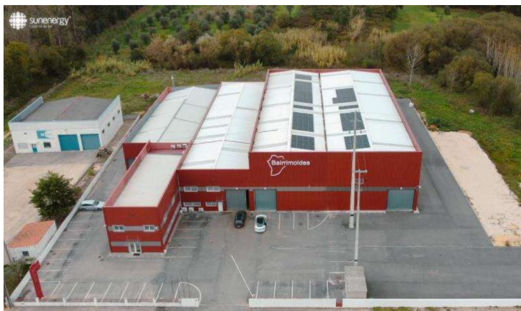
Figura 6.16 UPAC instalada na Bairrimoldes
