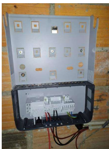
Figura 6.37 Instalação da armadura do inversor Fronius Galvo 3.0kW
