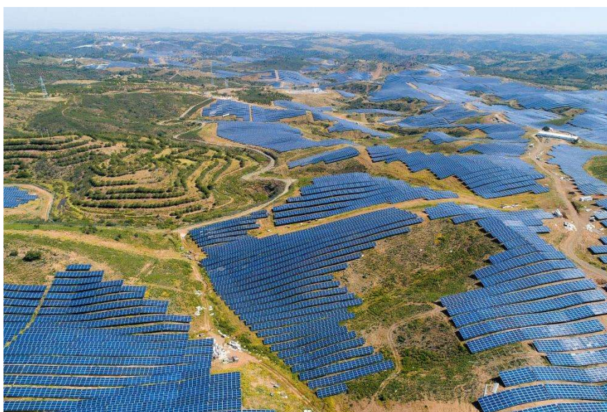
Figura 3.4 Central fotovoltaica de Alcoutim (Static, s.d.)
