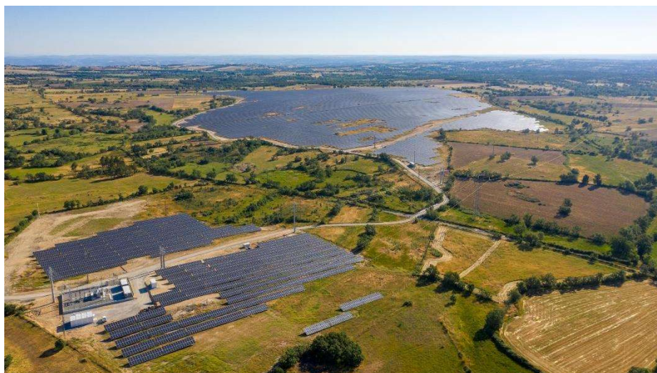
Figura 3.5 Central fotovoltaica Mogadour
