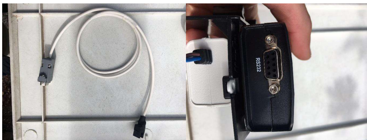
Figura 6.35 Substituição de modem de comunicação
