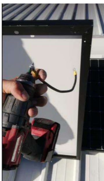
Figura 6.14 Chicote com ligação à terra
