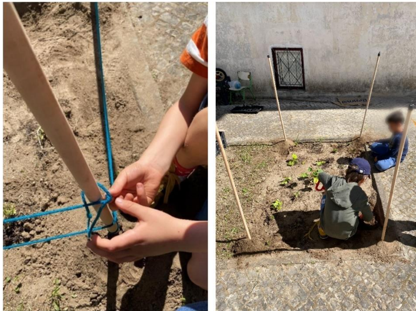
Figura 13 - Construção da cerca
