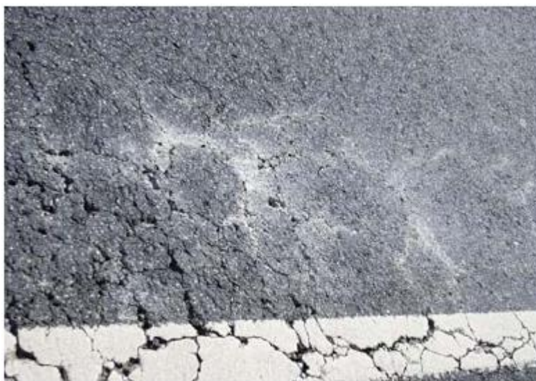
Figura 2.4 Pele de crocodilo – Serra da Leba.
