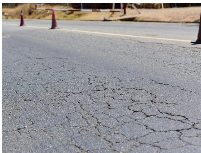
Figura 3.6- Pele de crocodilo de malha estreita – Estrada da serra da Leba.
