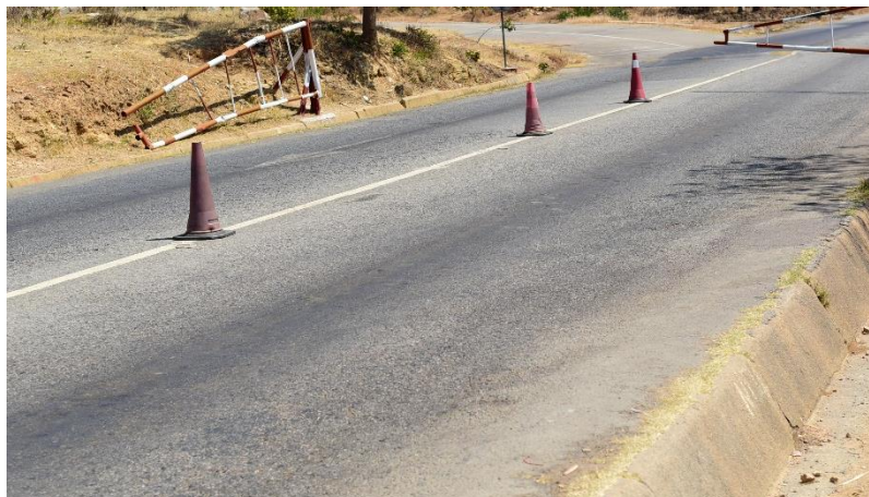
Figura 3.5- Rodeira no pavimento da estrada da serra da Leba
