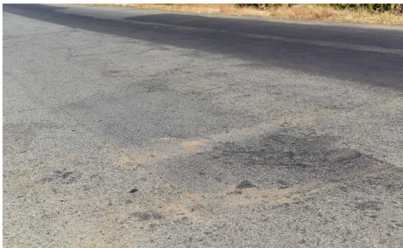
Figura 2.7 Reparação no Pavimento- Serra da Leba
