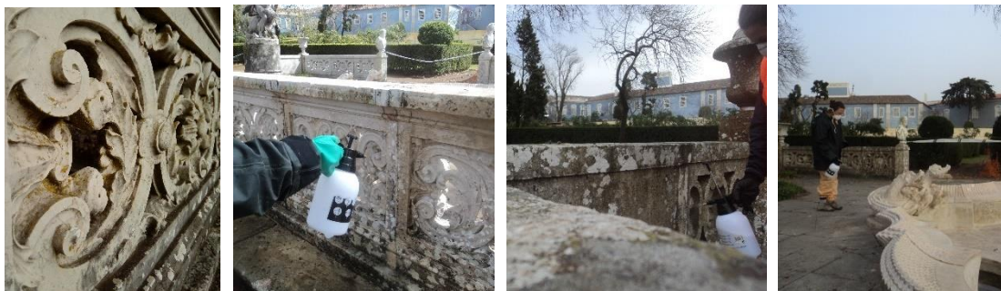
Figura 40 – Aplicação de biocida na balaustrada e no pavimento
