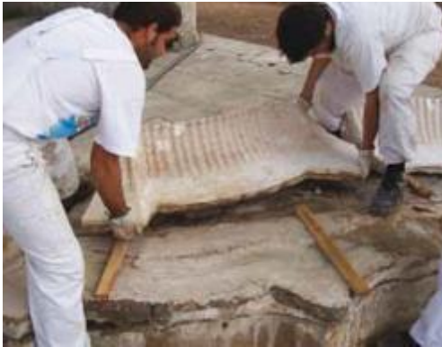
Figura 58 -“Reassentamento das peças da moldura do Lago dos Dragões, após limpeza de raízes, de depósitos terrosos e nivelamento da base” do livro «Os Jardins do Palácio Nacional de Queluz: intervenção de conservação» (BARROS e al] 2012)
