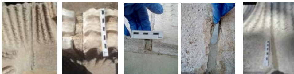
Figura 34 - Junta fechada (1ª à esquerda), Imagem comparativa de áreas micro estucadas, antes (2ª e 3ª imagens) e depois da intervenção (4ª e 5ª imagens)
