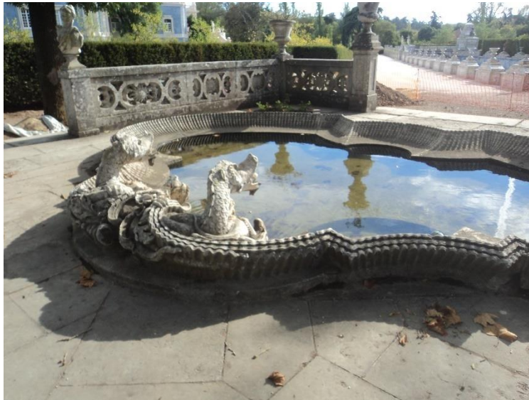
Figura 14 – Obra antes da intervenção de estágio
