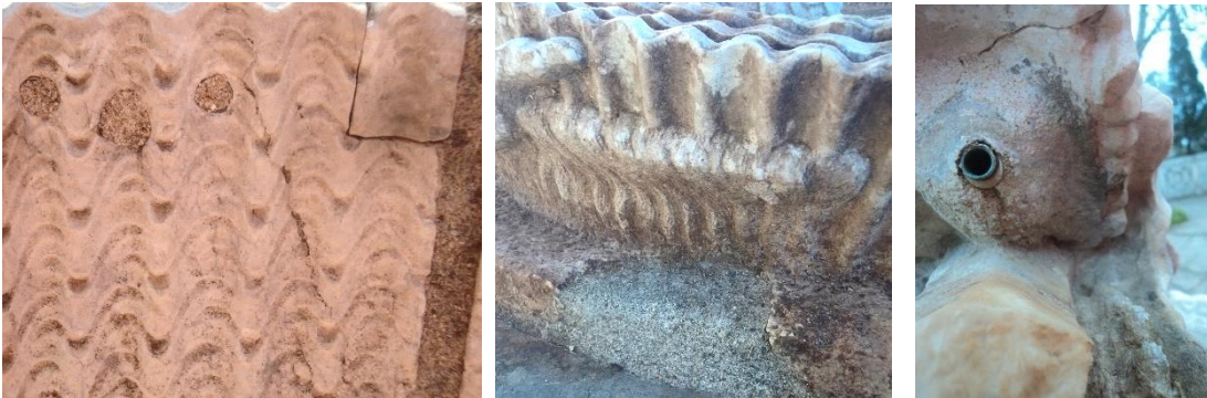
Figura 16 – aplicações de argamassa de intervenções anteriores, colagens e aplicação de novos tubos de alimentação
