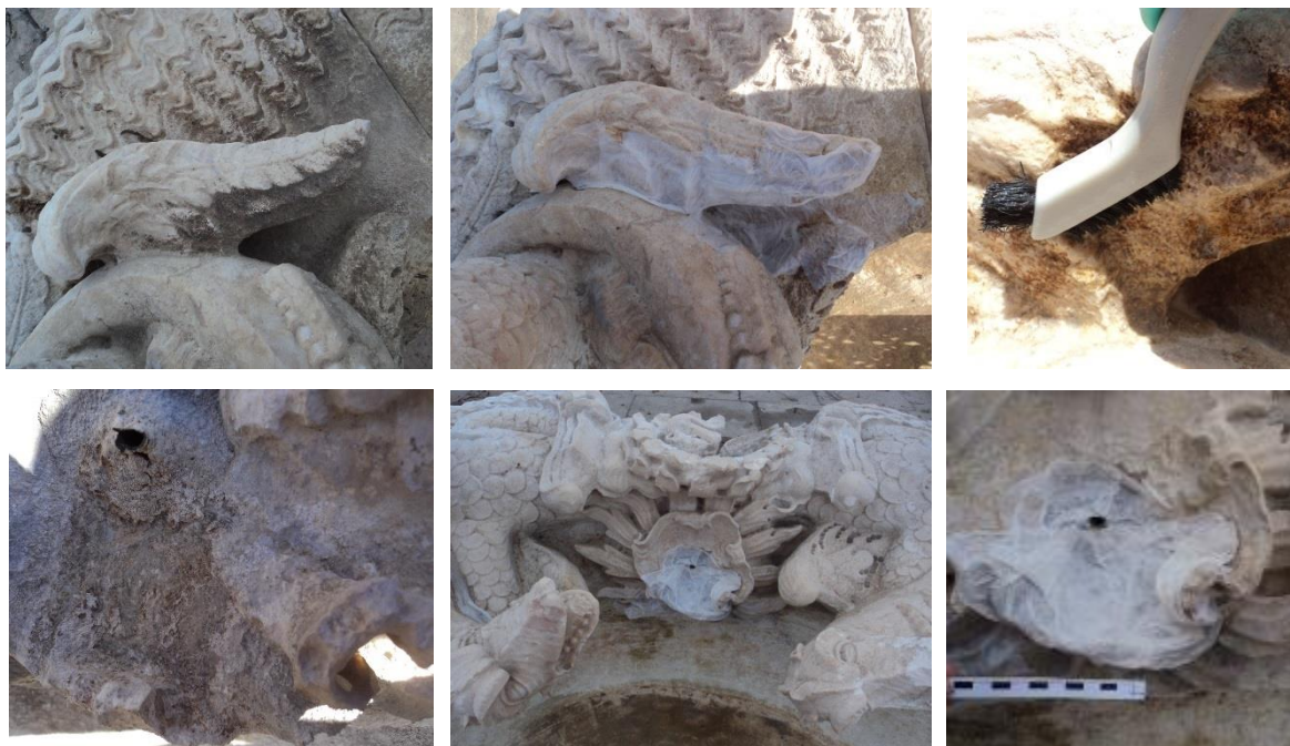
Figura 29 – Utilização dos pachos com bicarbonato de amónio e consequente remoção e limpeza com escovas
