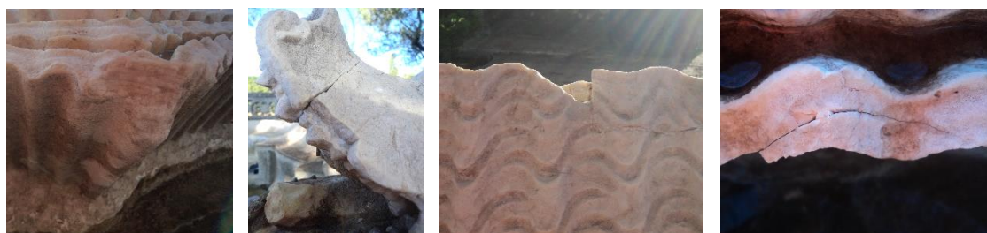
Figura 15 – Lacunas, fendas e fissuras existentes na obra
