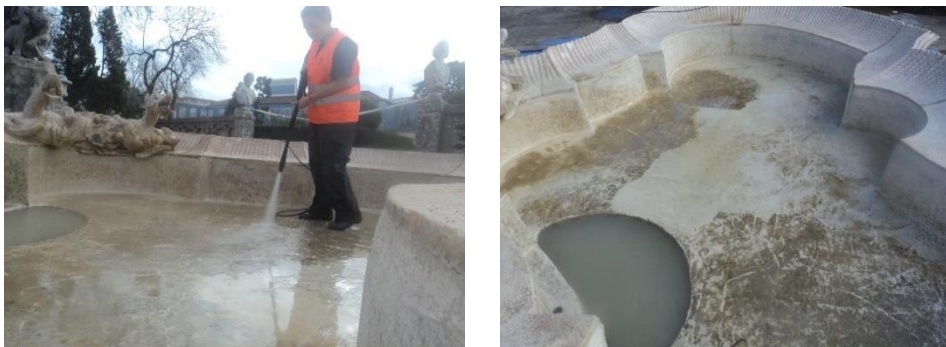
Figura 33 – Limpeza com água projetada
