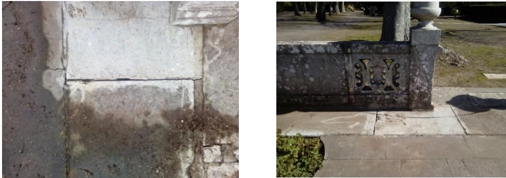
Figura 42 – Limpeza com água projetada
