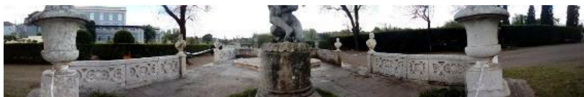
Figura 44 – Limpeza geral, antes e depois, vista frontal.
