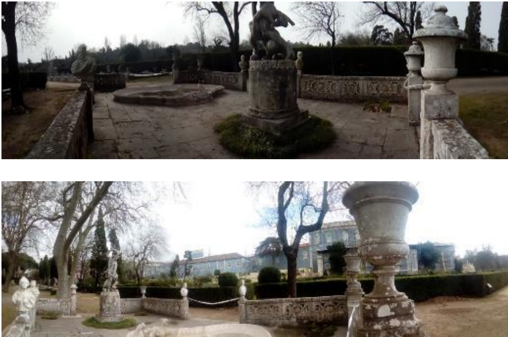
Figura 38 – Plinto envolvente da obra em intervenção antes da ação de conservação
